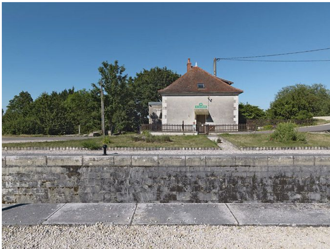
Maison éclusière vue de face. Elle ne présente pas de fenêtre de ce côté, ce qui n'est pas conforme au modèle de cette série. 21, Longvic, lieudit : bief 59 du versant Saône
