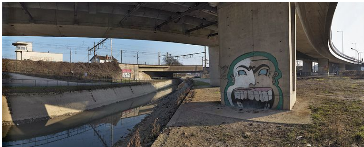
Pont routier permettant le passage des boulevards John Kennedy et Maillard vu du dessous. A l'arrière-plan : pont ferroviaire. 21, Dijon, lieudit : bief 56 du versant Saône
