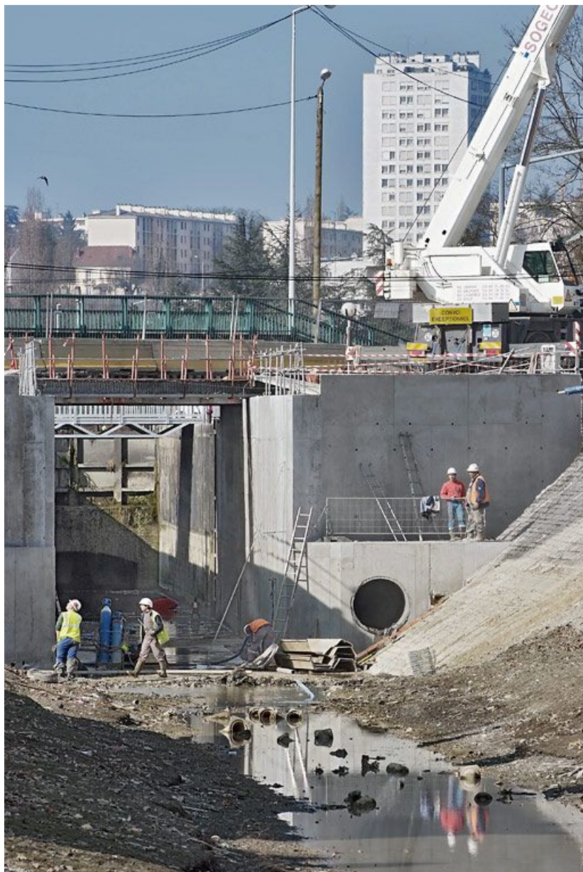
Le bief 56 est vide pour refaire le pont. On voit nettement à droite la sortie ronde de l'aqueduc qui aide au fonctionnement du sas. 21, Dijon, lieudit : Port du canal
