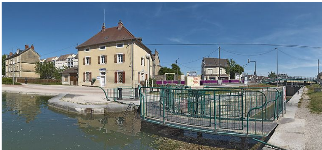
Façade de la maison éclésièrè donnant sur le port. A droite, le sas. Sur la gauche, on aperçoit la maison de perception. 21, Dijon, lieudit : port du Canal
