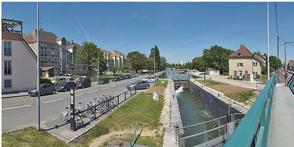
Vue d'ensemble du site d'écluse prise d'aval. En arrière-plan, le port de Dijon.
