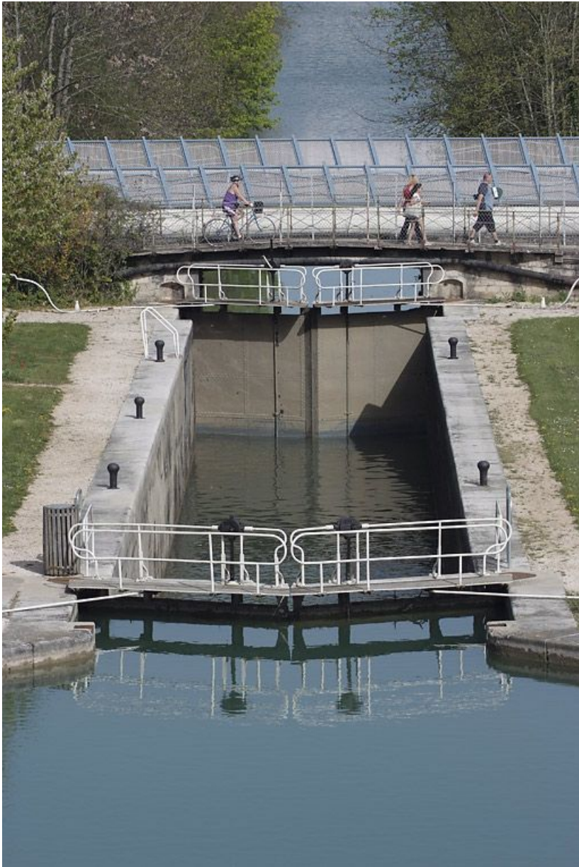
Tête aval de l'écluse 54, avec le pont ancien sur écluse doublé par le pont moderne. 21, Dijon, lieudit : Larrey
