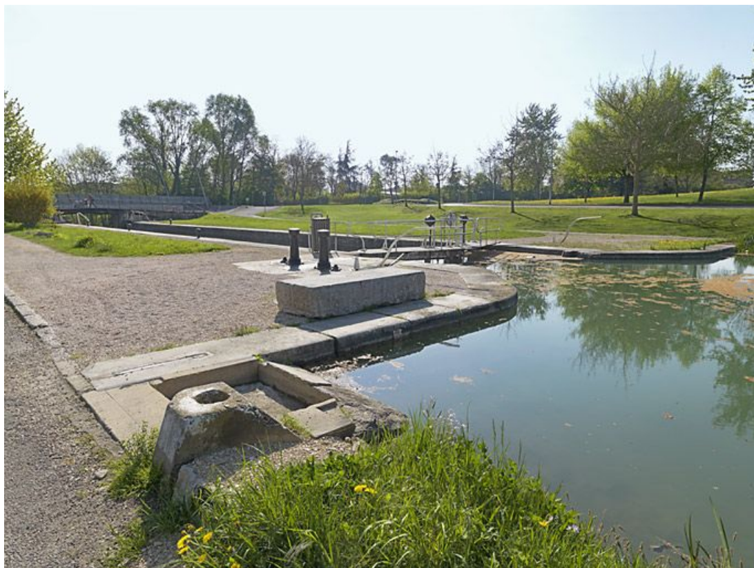
Le sas vu de la tête amont rive gauche. A gauche : le lavoir domestique du site d'écluse. En arrière-plan, les ponts sur écluse, (ancien IA21003790 et nouveau IA21003791).
