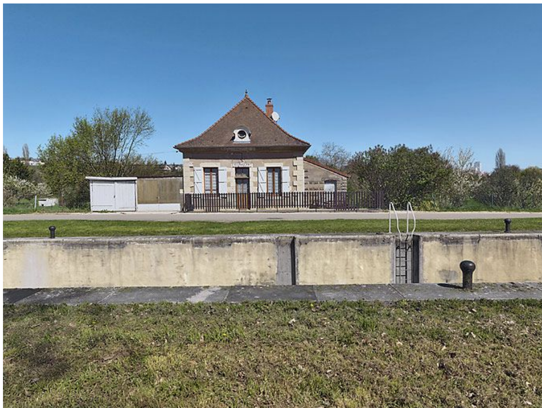
Vue d'ensemble du site d'écluse vu de face.
