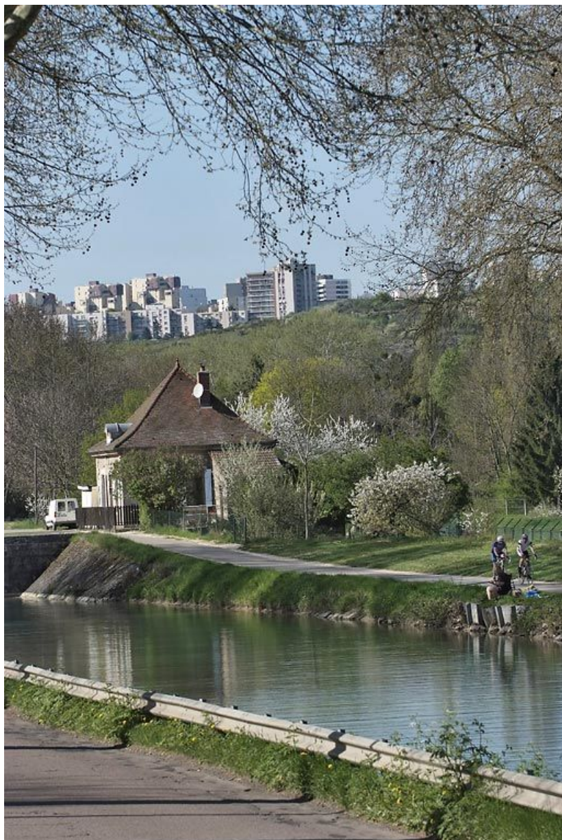
Le site d'écluse vu d'aval avec la colline de Talant en arrière-plan. 21, Dijon, lieudit : Fontaine-d'Ouche
