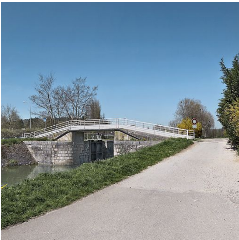
Le pont sur écluse a été rehaussé en passerelle pour piétons. On voit nettement les piles de l'ancienne construction. Vue d'aval. 21, Dijon, lieu dit : Fontaine-d'Ouche
