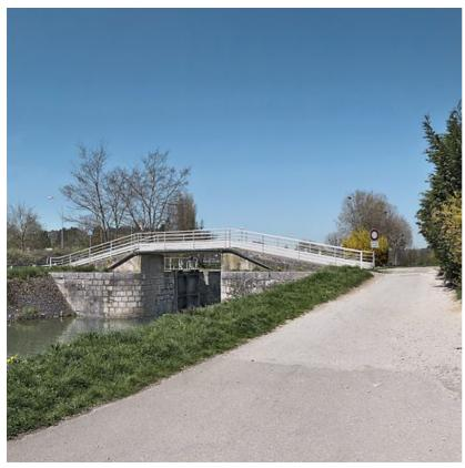
Le pont sur écluse a été rehaussé en passerelle pour piétons. On voit nettement les piles de l'ancienne construction. Vue d'aval.
