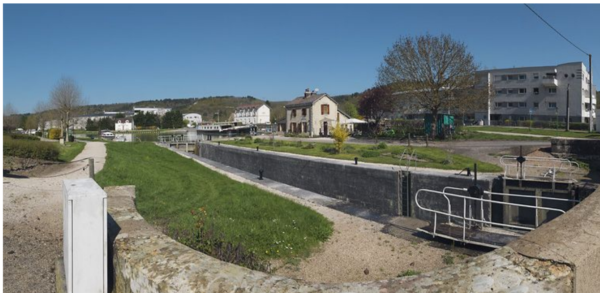
Le site d'écluse vu d'aval, avec le port de Plombière en fond.
