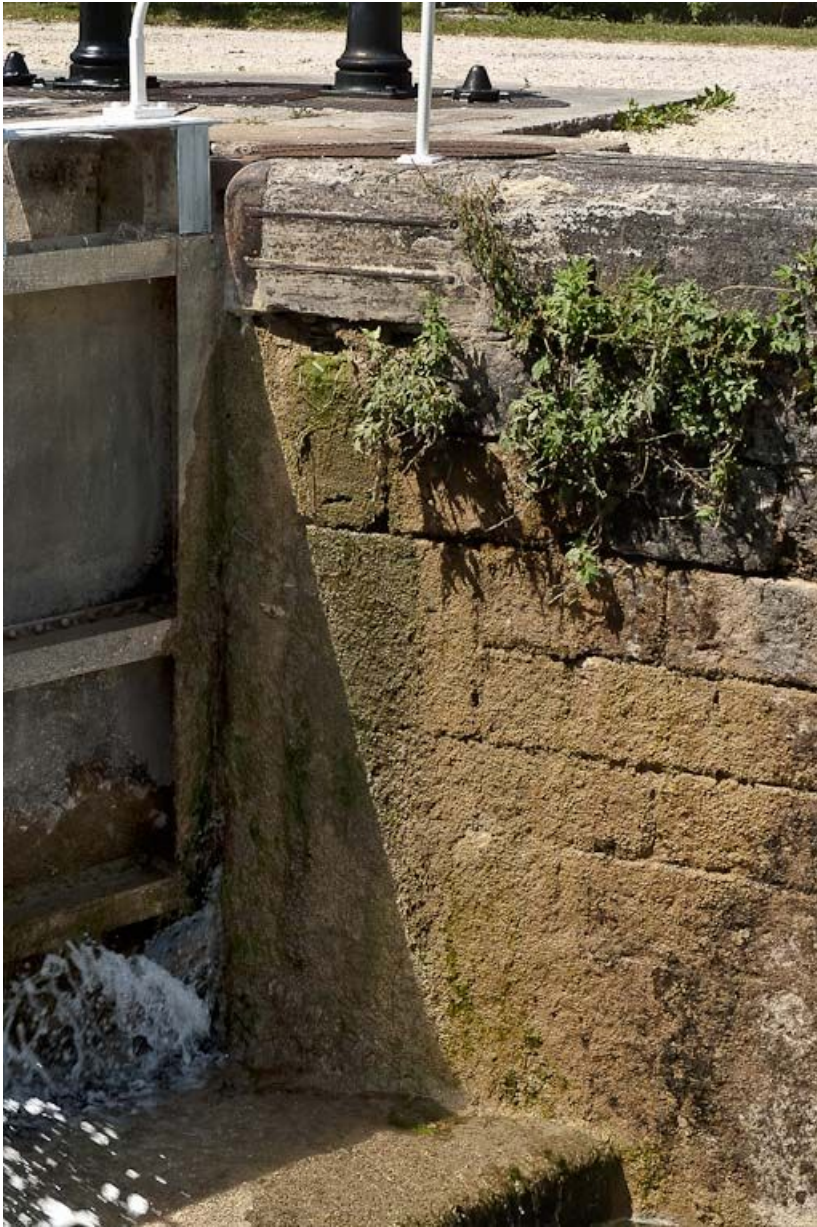
Détail de la maçonnerie du sas d'écluse.
