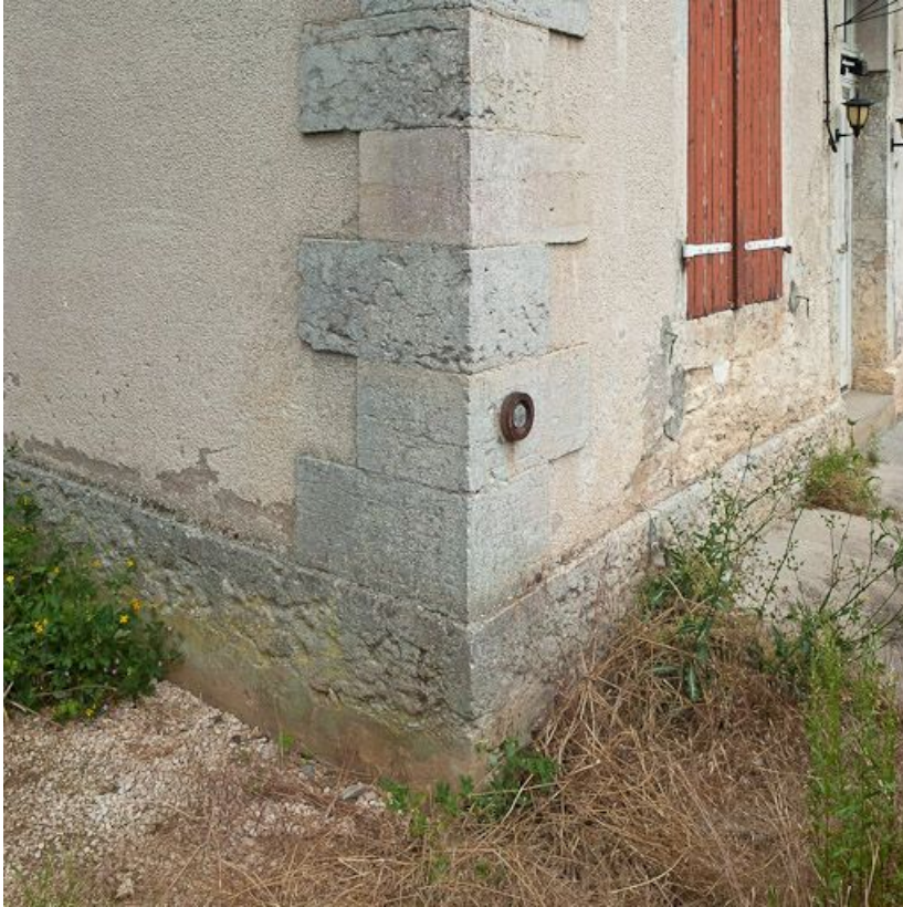
Détail des matériaux de la maison éclusière : chaîne d'angle et soubassement.
