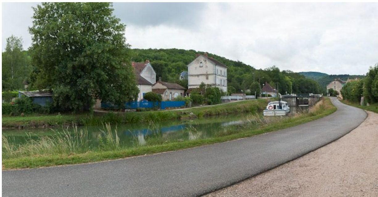
Vue de la maison de garde et de la maison de perception de Pont-de-Pany.
