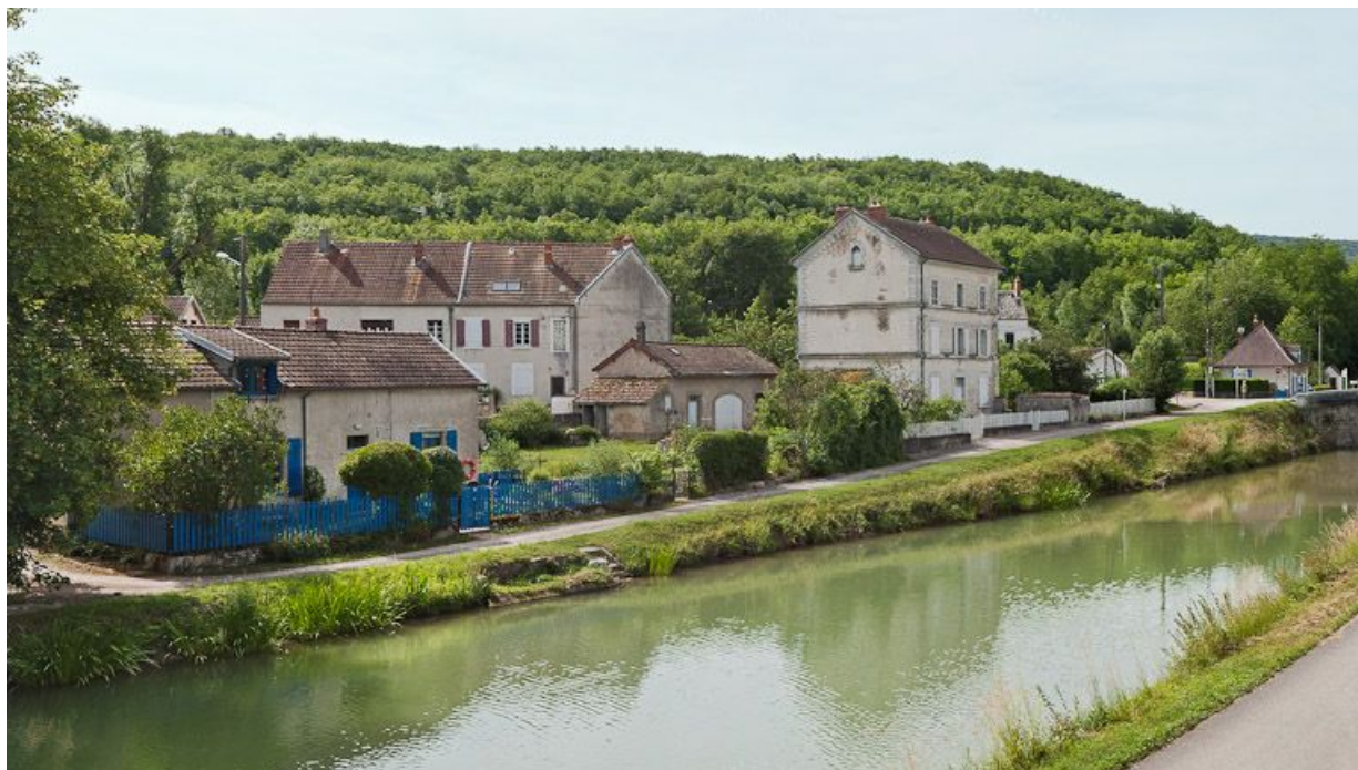
De gauche à droite, vue des trois maisons de Pont-de-Pany : maison de garde, maison de perception, maison éclusière. 21, Sainte-Marie-sur-Ouche, lieudit : Pont-de-Pany
