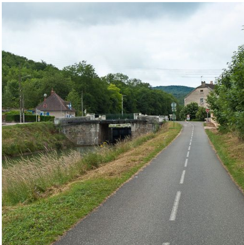
Vue du pont sur écluse depuis l'aval.
