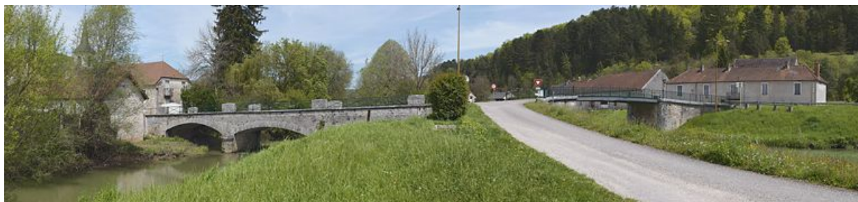
Pont de la fin du 19e siècle sur le canal et pont plus ancien en pierre sur l'Ouche.
