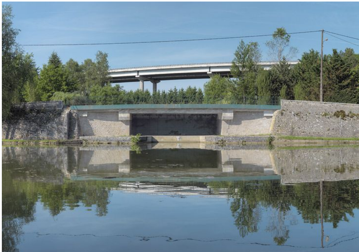
Le viaduc surplombant le pont sur l'ancienne gare d'eau des houillères d'Épinac.
