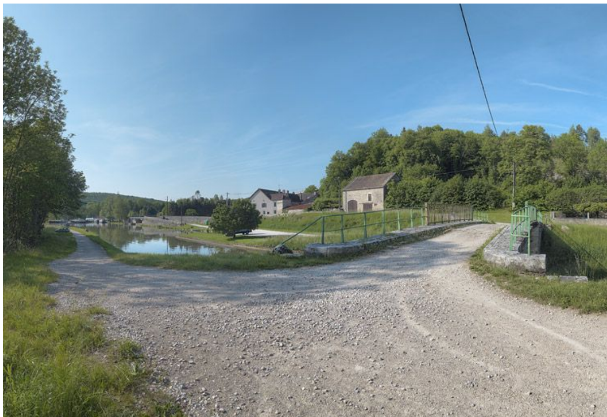
Le pont isolé de Crugey vu d'amont. Port en arrière-plan.
