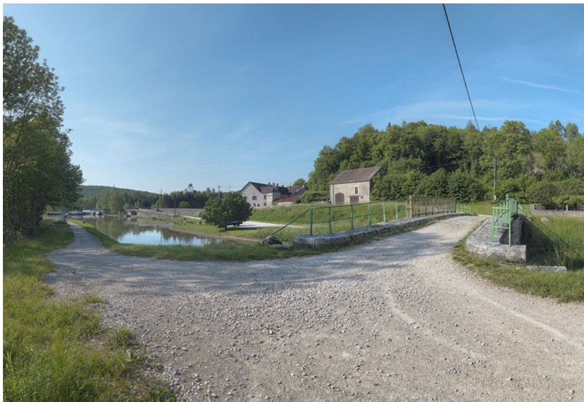
Le pont isolé de Crugey vu d'amont. Port en arrière-plan.
