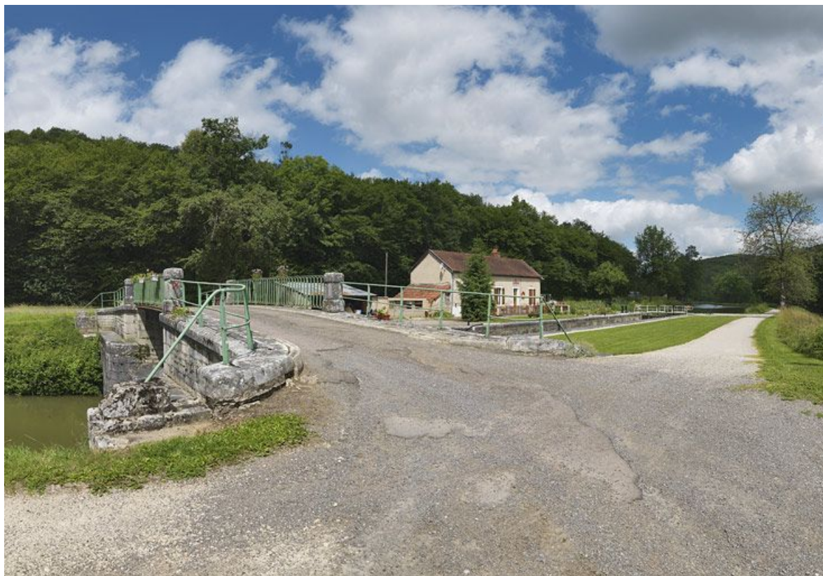
Vue d'ensemble du site d'écluse prise de l'aval, avec le pont sur écluse.
