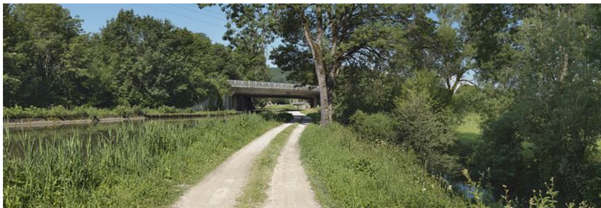
Le viaduc autoroutier dans son environnement. Derrière lui, un pont routier isolé.
