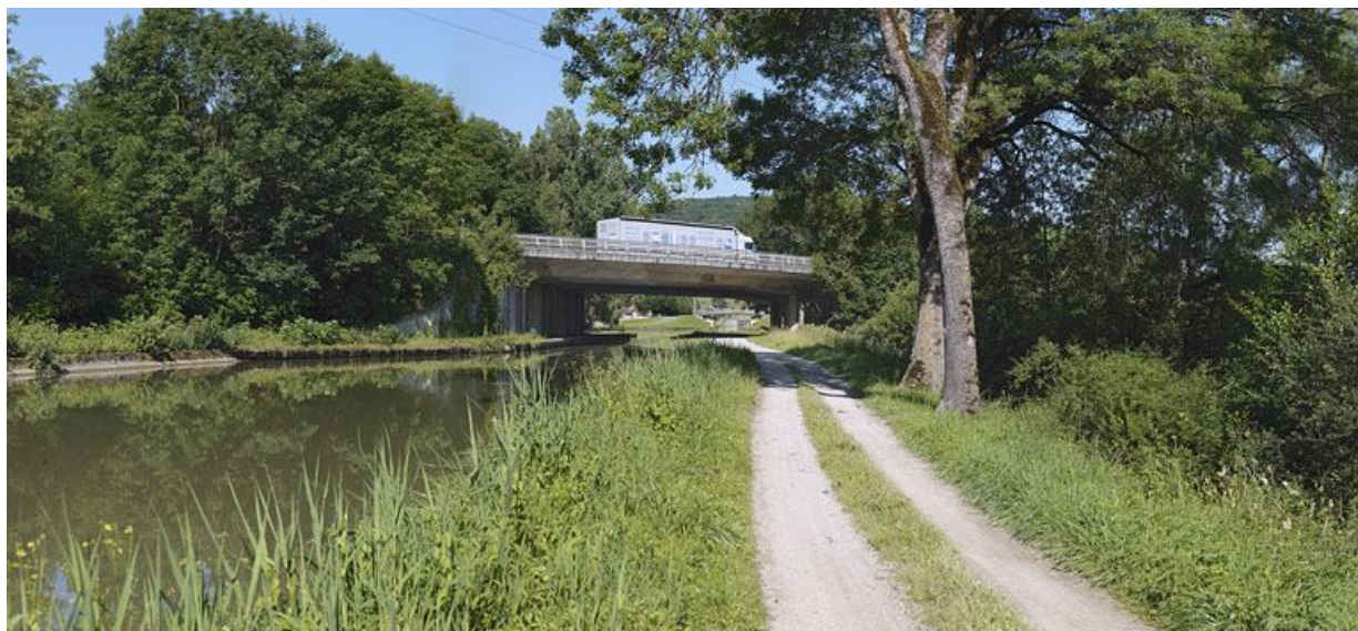
Le viaduc autoroutier dans son environnement. Derrière lui, un pont routier isolé.
