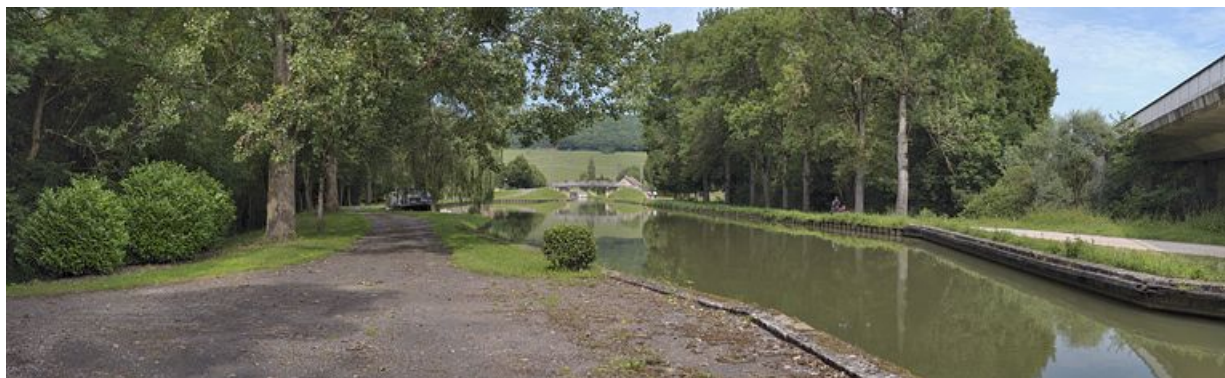
Le port de Crugey entre le pont autoroutier (à droite) et le pont routier isolé au fond.
