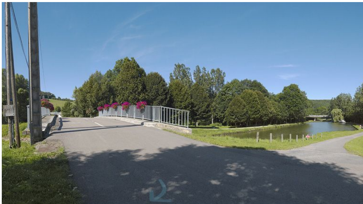
Le pont isolé de Crugey : le port de Crugey, le viaduc en arrière-plan.
