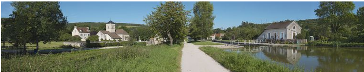
Le paysage en amont du site d'écluse 16. Sur la gauche, l'église et le presbytère de Crugey. 21, Crugey, lieudit : bief 16 du versant Saône
