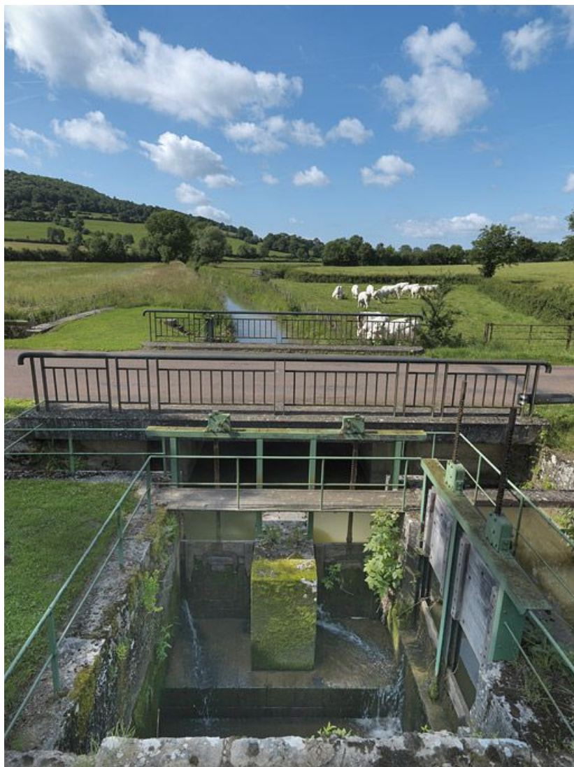
Point de rencontre de la rigole d'alimentation issue du réservoir du Tillot et du ruisseau de la Miotte, en amont du site d'écluse 13. 21, Sainte-Sabine, lieudit : bief 13 du versant Saône
