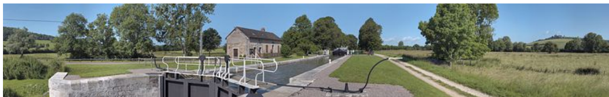
Vue d'ensemble du site d'écluse, pris de l'aval. Le château de Châteauneuf en arrière-plan. 21, Sainte-Sabine, lieudit : bief 13 du versant Saône
