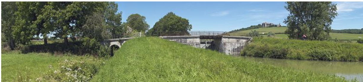
Pont sur la rigole du Tillot, et dans la continuité, le pont sur écluse. Le château de Châteauneuf en arrière-plan.
