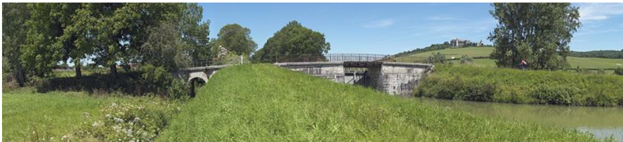
Pont sur la rigole du Tillot, et dans la continuité, le pont sur écluse. Le château de Châteauneuf en arrière-plan.
