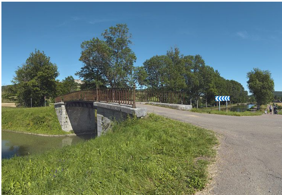
Vue d'ensemble avec château de Châteauneuf en arrière-plan.
