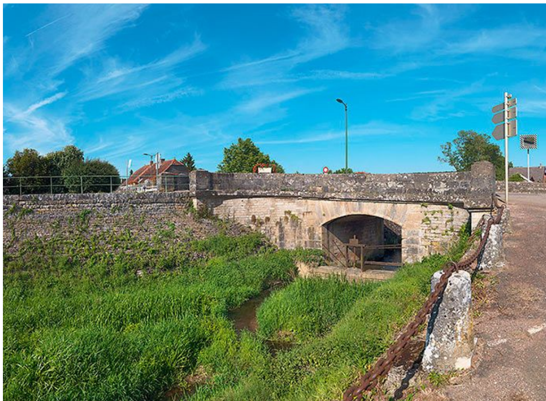
Le pont en moellon et pierre de taille sur la Vandenesse, à la suite du pont sur écluse.
