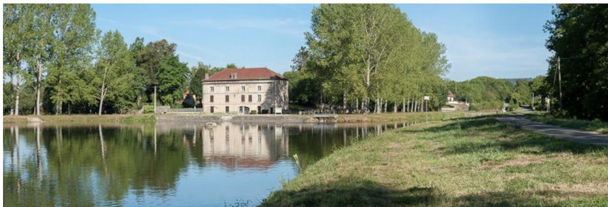
Vue du port et de la cimenterie depuis la rive gauche.
