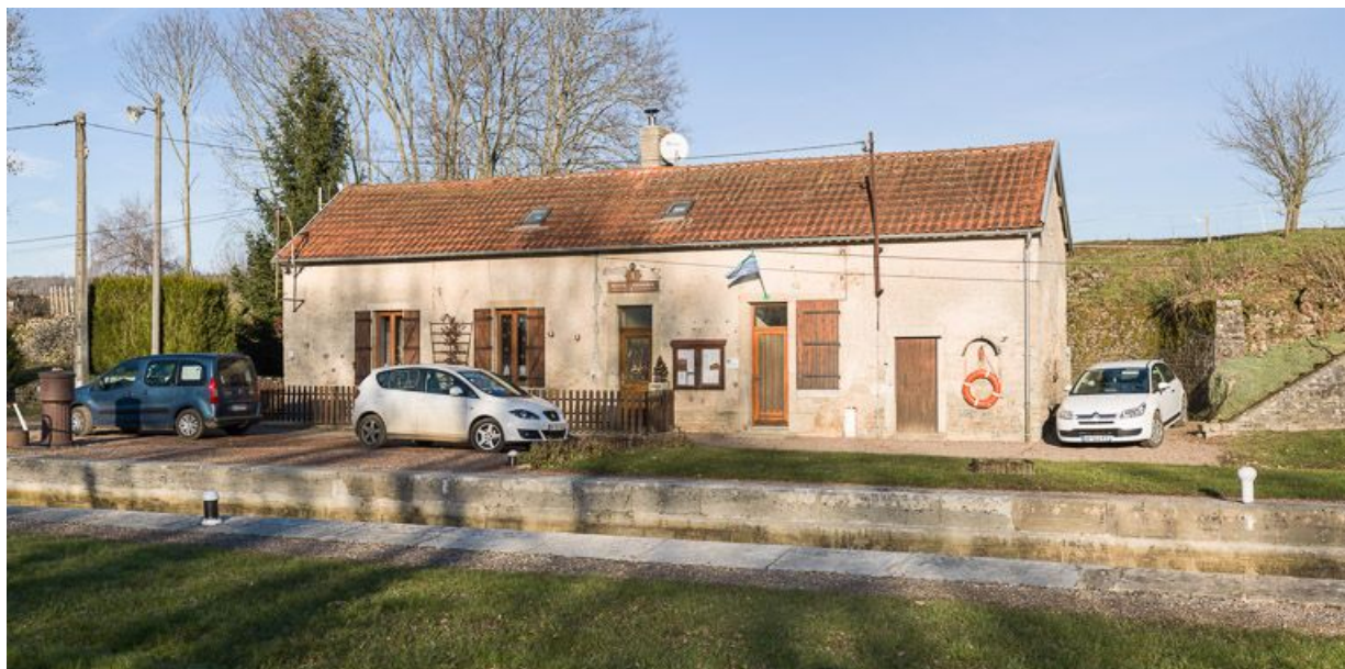
La maison éclusière vue de 3/4.
