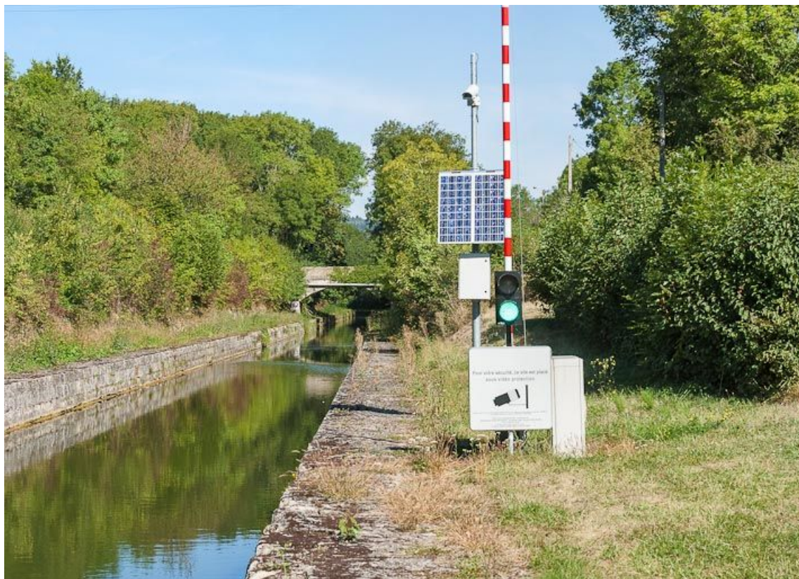
Vue d'ensemble de la tranchée de Créancey, depuis l'aval.
