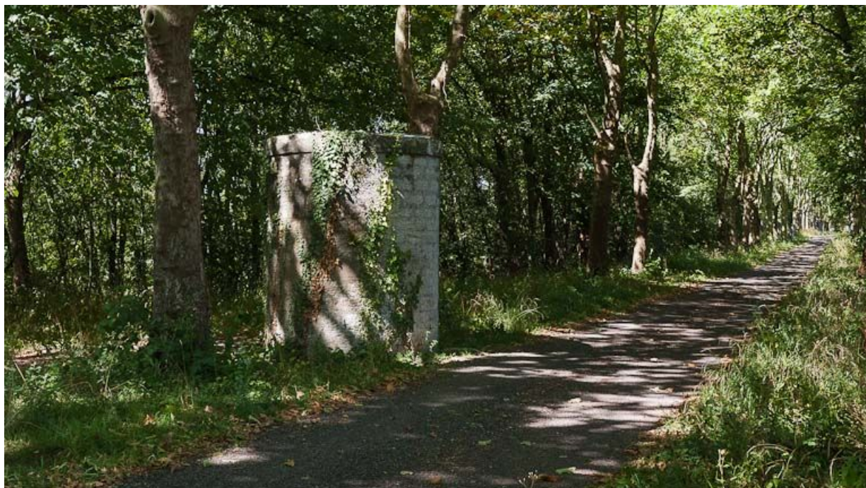
Vue d'un puits d'aération du tunnel.
