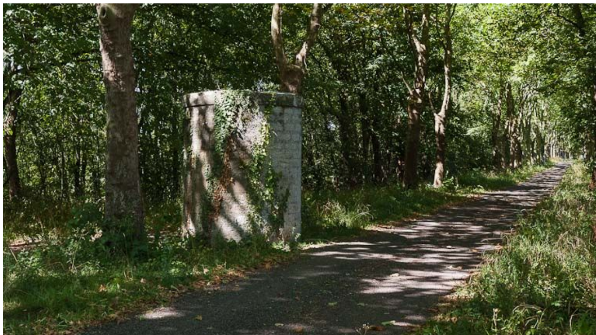
Vue d'un puits d'aération du tunnel.
