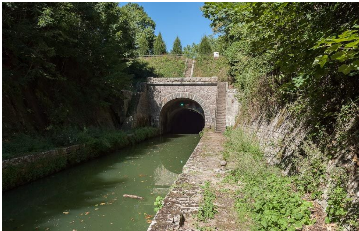
Vue de l'entrée du tunnel à Créancey.
