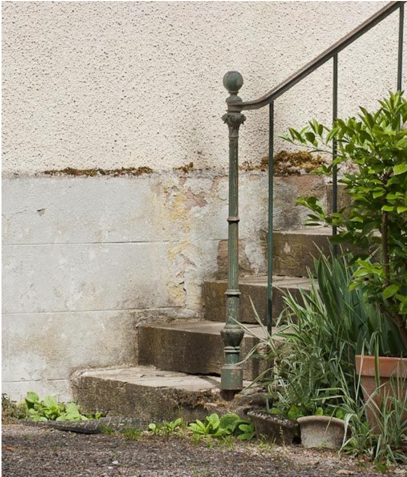
Détail d'un départ de rampe.
