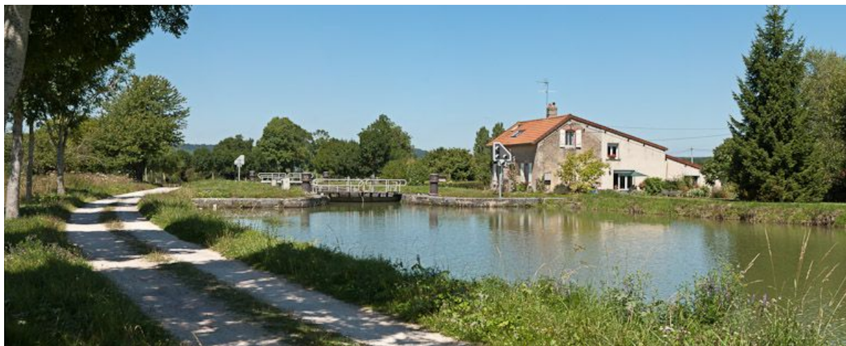
Site de l'écluse 05 du versant Yonne, dite de Pelleson, à Thoisy-le-Désert : vue d'ensemble.
