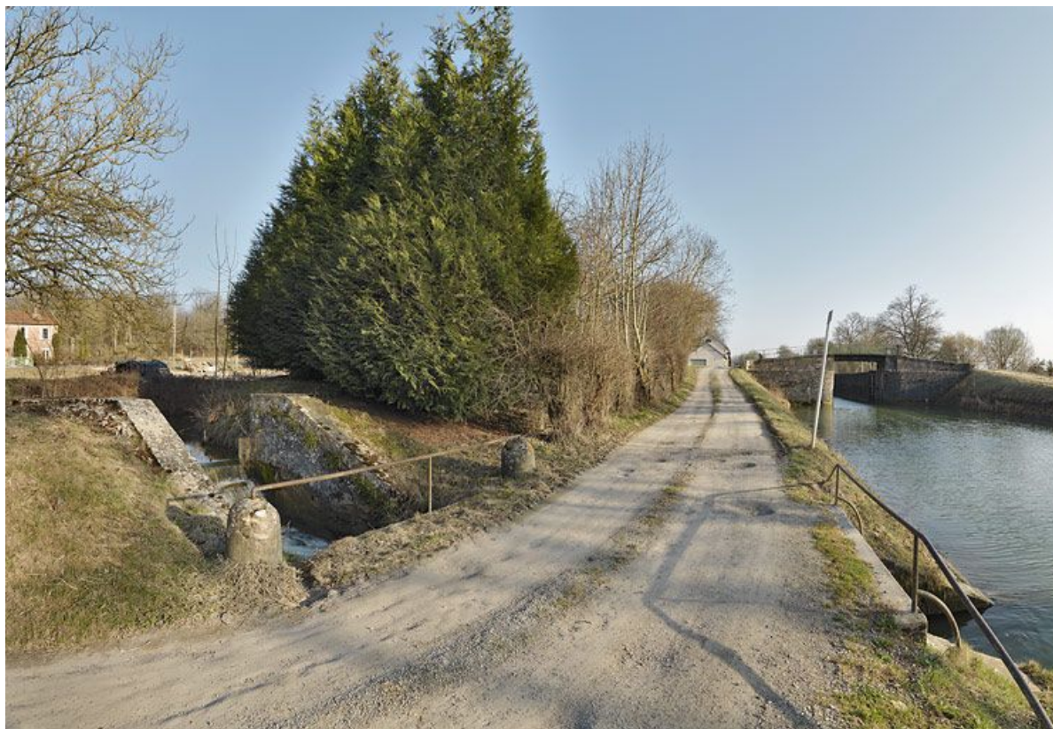
Passage de la rigole d'alimentation sous le chemin de halage et sous le canal.
