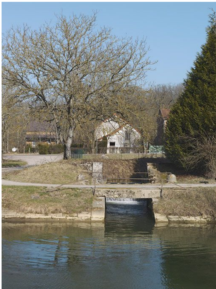
Entrée de la rigole d'alimentation dans le canal. 21, Gisse-le-Vieil, lieudit : bief 12 du versant Yonne
