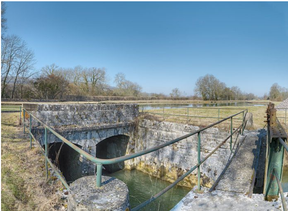
Arrivée de la Brionne vers le canal : vannes et aqueduc à deux arches.
