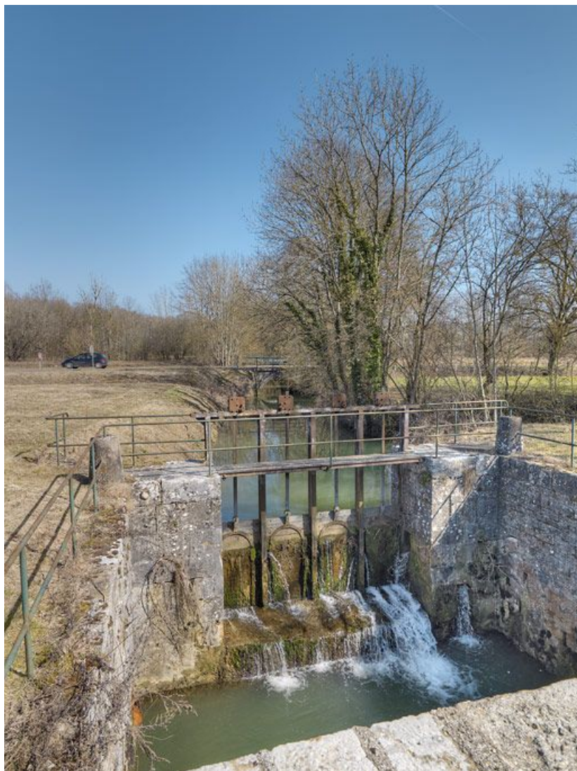
Arrivée de la Brionne vers le canal : les vannes prises de l'aqueduc.
