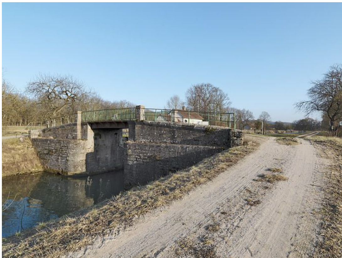
Le pont sur écluse vu d'aval.
