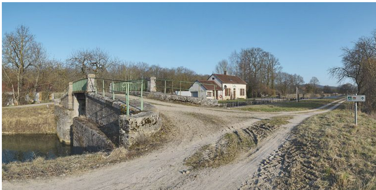
Le site d'écluse vu d'aval, avec son pont.
