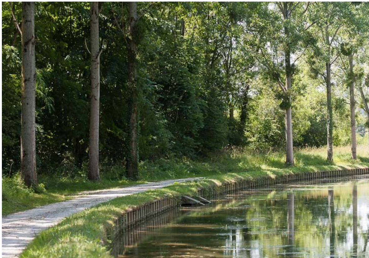
Bief 75 du versant Yonne à Ravières : le déversoir côté canal.
