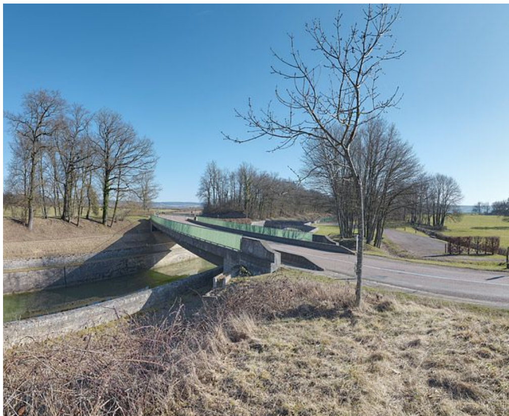
Vue d'ensemble du pont moderne. En arrière-plan : le pont ancien.
