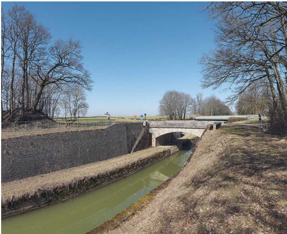
Le pont en pierre de l'amont, avec un des deux escaliers d'accès à la banquette de halage de la tranchée. Derrière le pont plus récent.
