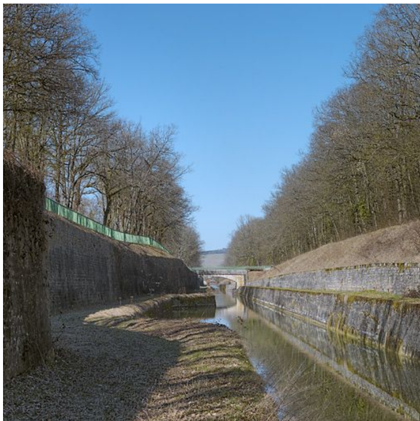
L'entrée de la tranchée du Creusot. Au fond : les ponts.
