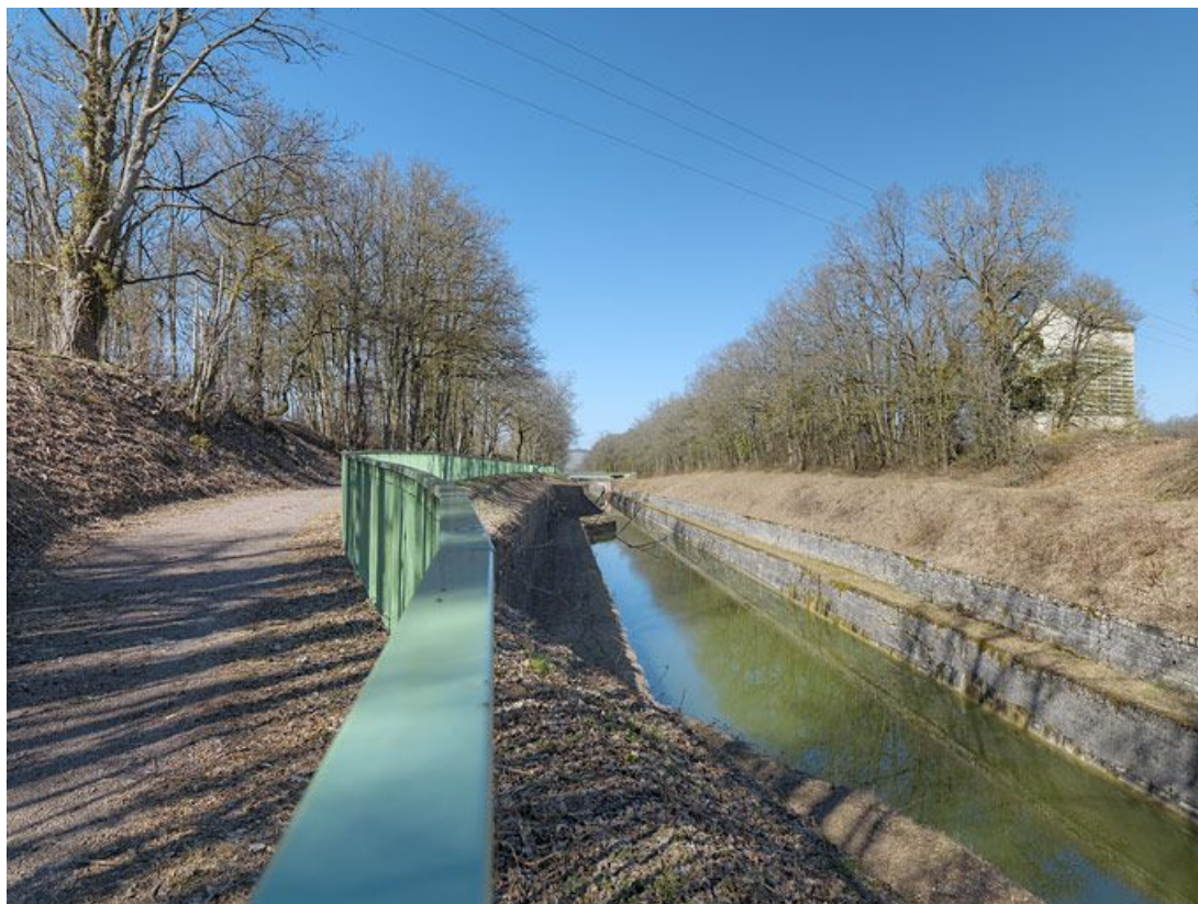
L'entrée de la tranchée du Creusot. Au fond : les ponts.
