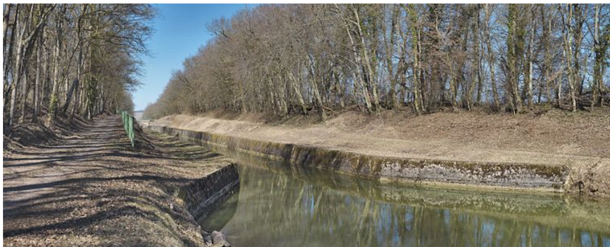
L'entrée de la tranchée du Creusot. Au fond : les ponts.
