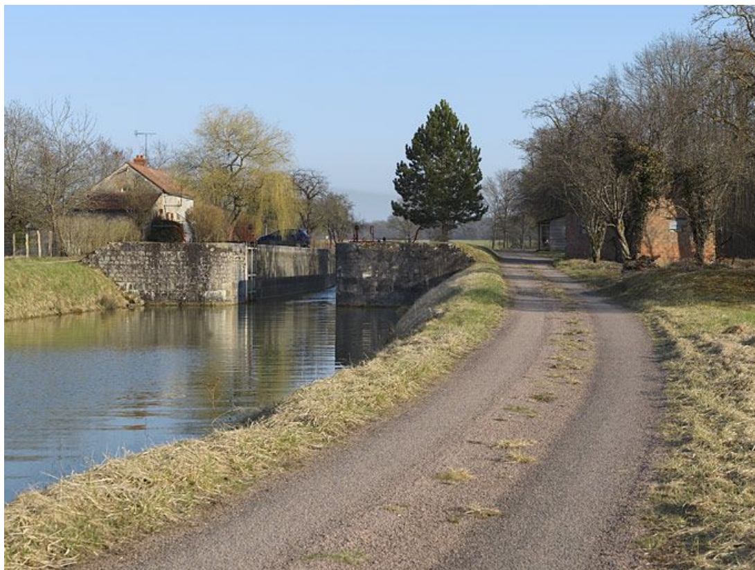
Le site d'écluse vu d'aval avec sa remise.
