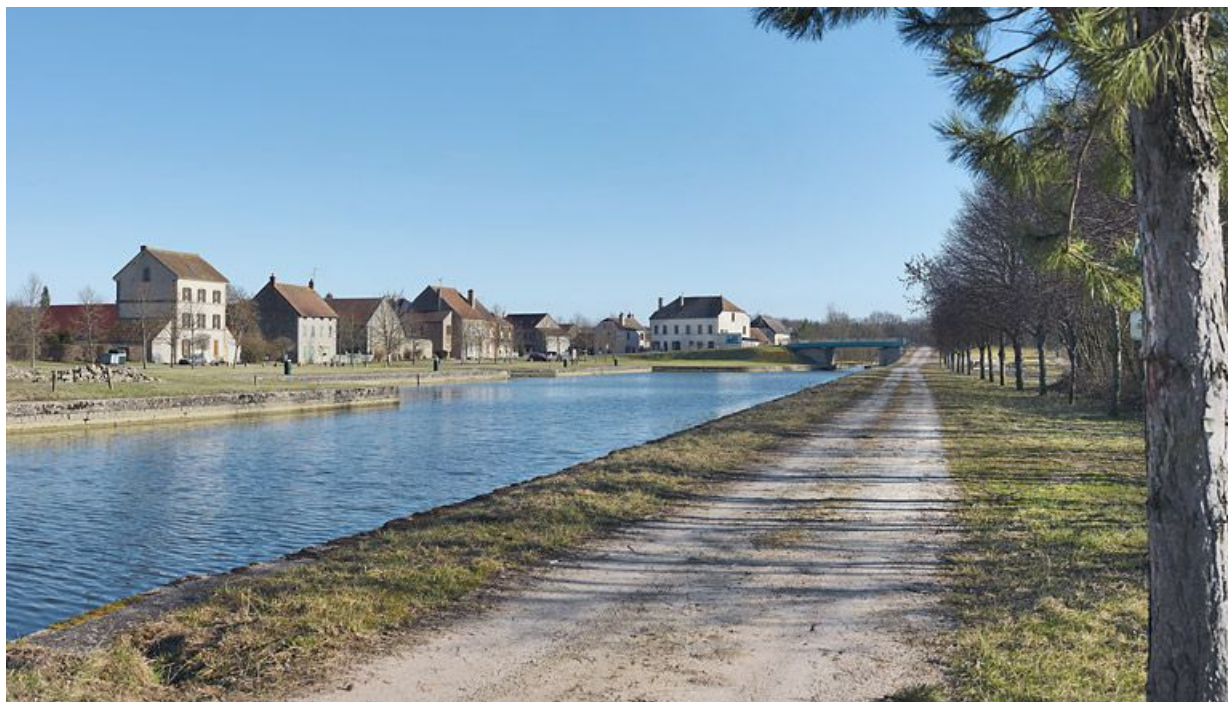
Vue d'ensemble du port pris d'aval, à l'arrière-plan : pont routier.
