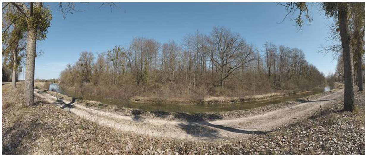
Vue d'ensemble de la tranchée avec le site d'écluse 15 en fond.
