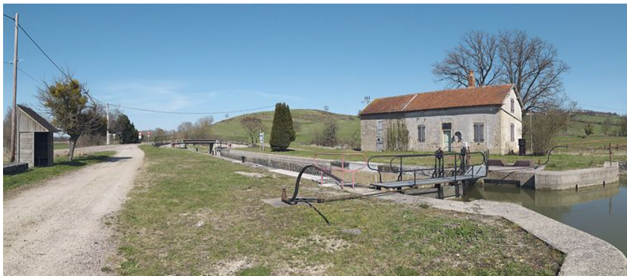
Le site d'écluse vu d'amont : la maison éclusière avec son annexe.
