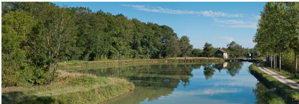
Vue de la gare d'eau située en amont du site d'écluse 37 du versant Yonne.
