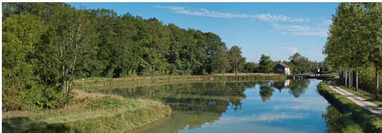
Vue de la gare d'eau située en amont du site d'écluse 37 du versant Yonne.
