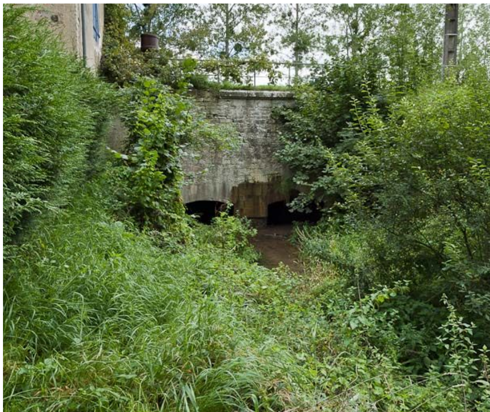
Vue de l'aqueduc passant sous le site d'écluse.
