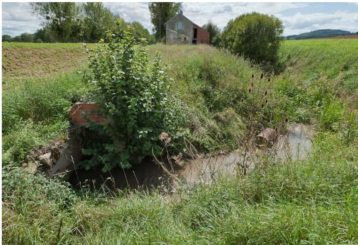
Vue de la rigole d'alimentation se déversant en aval du site d'écluse.
