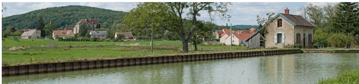
Vue du site d'écluse et du château de Venarey (IA21003512) à l'arrière-plan.
