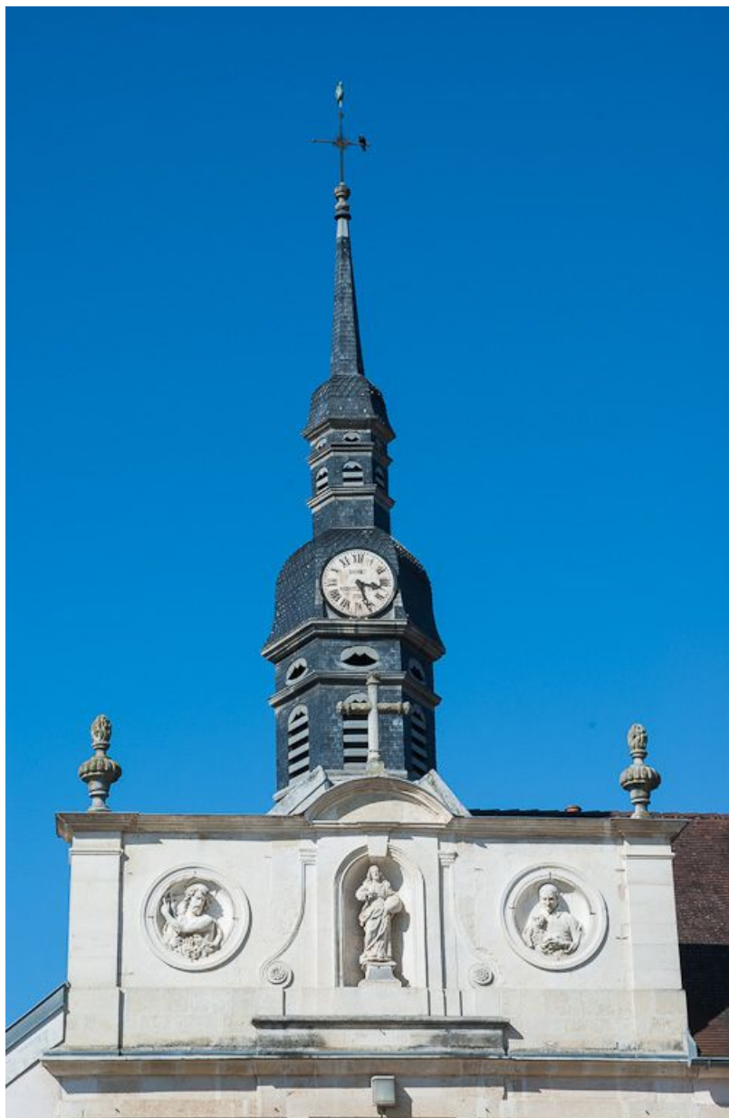
Façade sur rue : détail (clocher et attique de l'ancienne salle des hommes devenue chapelle). 21, Moutiers-Saint-Jean, 8 place de l' Hôpital
