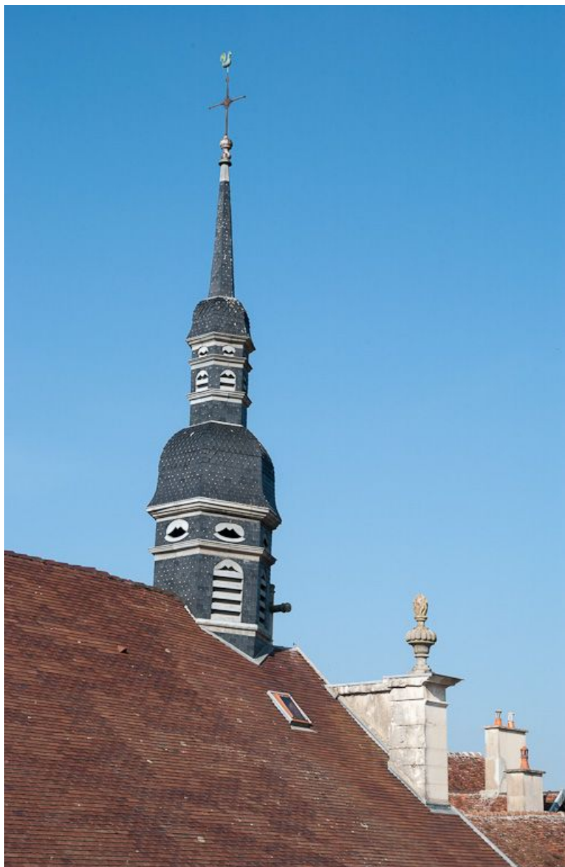
Clocher vu depuis la cour principale.
