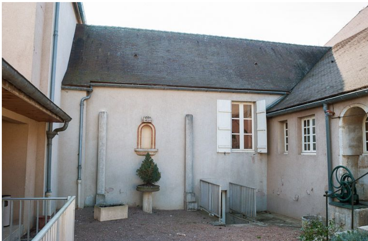
Corps de bâtiment transversal : élévation sur la cour principale.
