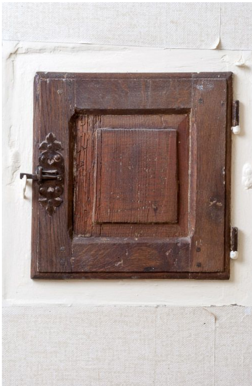
Corps de bâtiment principal : petite porte d'un placard mural du vestibule (mur nord). 21, Moutiers-Saint-Jean, 8 place de l' Hôpital
