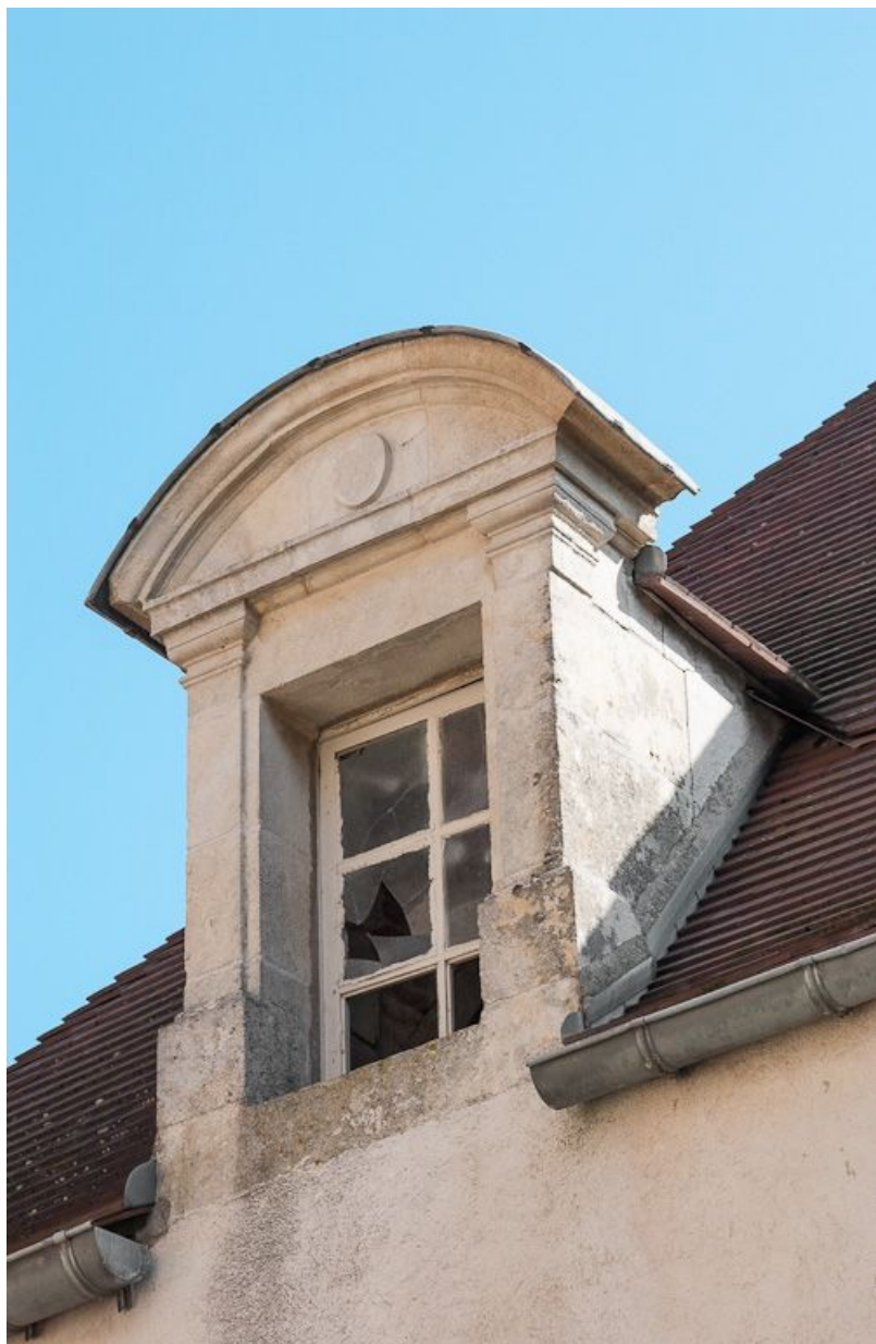
Corps de bâtiment principal : lucarne (élévation latérale ouest).
