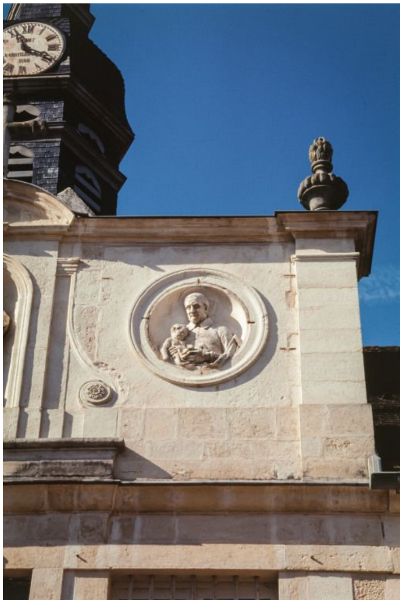
Détail de la façade de la chapelle : saint Vincent de Paul.
