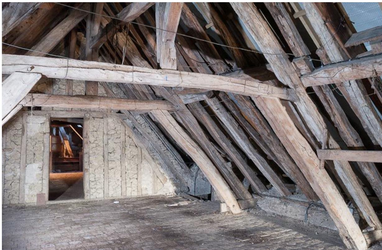
Corps de bâtiment principal : charpente (au-dessus de l'ancienne salle des femmes).
