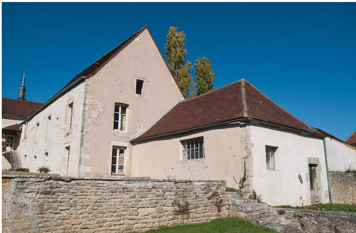
Ancien bûcher transformé en "salle d'asile" et ancien bâtiment du pressoir.
