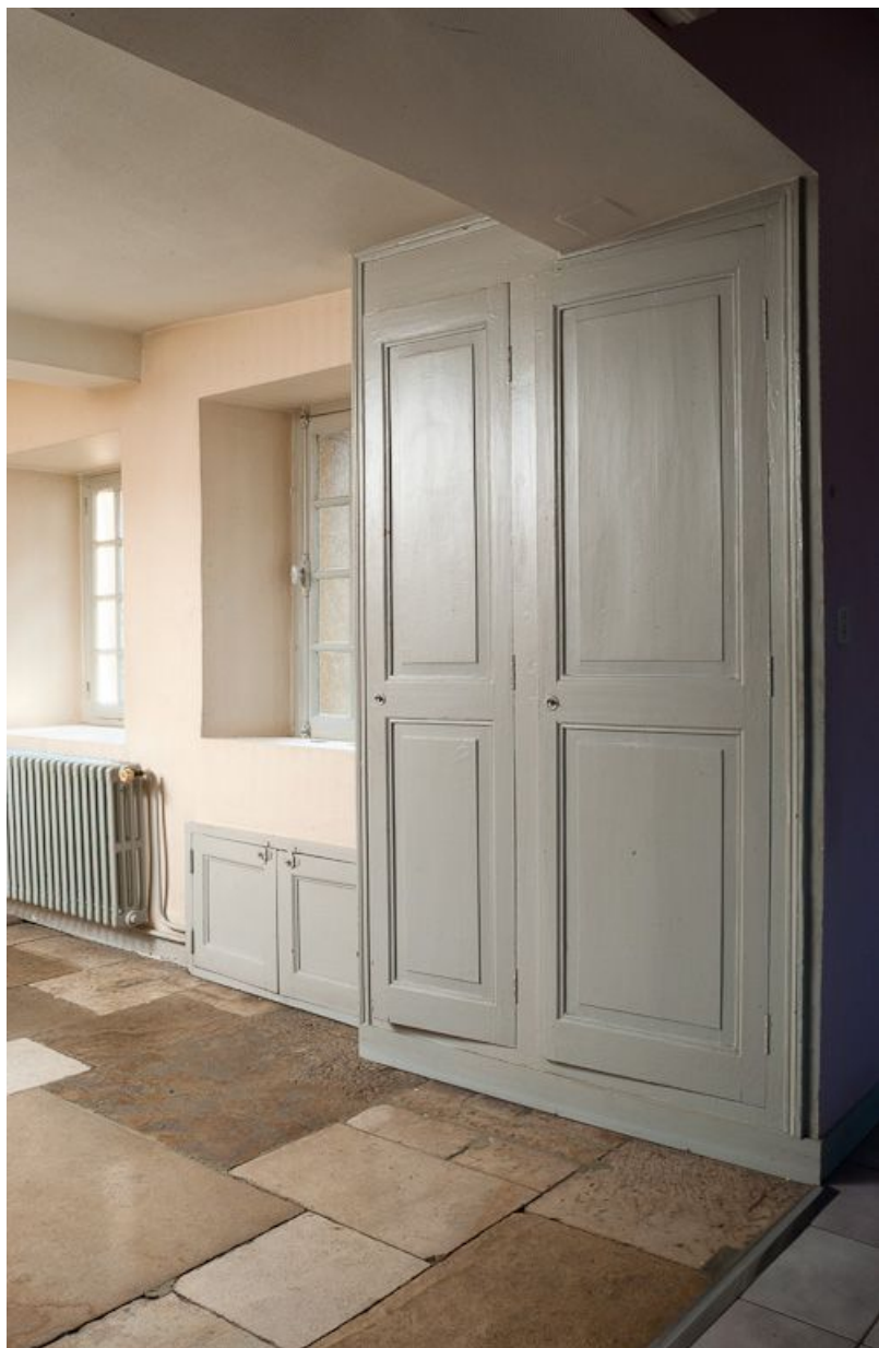
Corps de bâtiment principal : troisième pièce latérale gauche.
