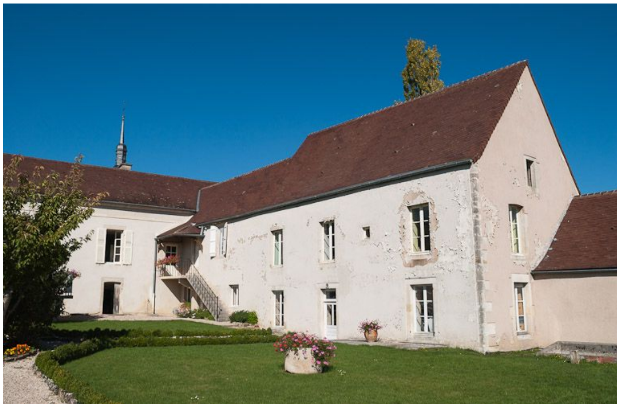
Vue d'ensemble des bâtiments à l'angle nord du jardin : bâtiment de l'apothicairerie et ancien bûcher transformé en "salle d'asile". 21, Moutiers-Saint-Jean, 8 place de l' Hôpital
