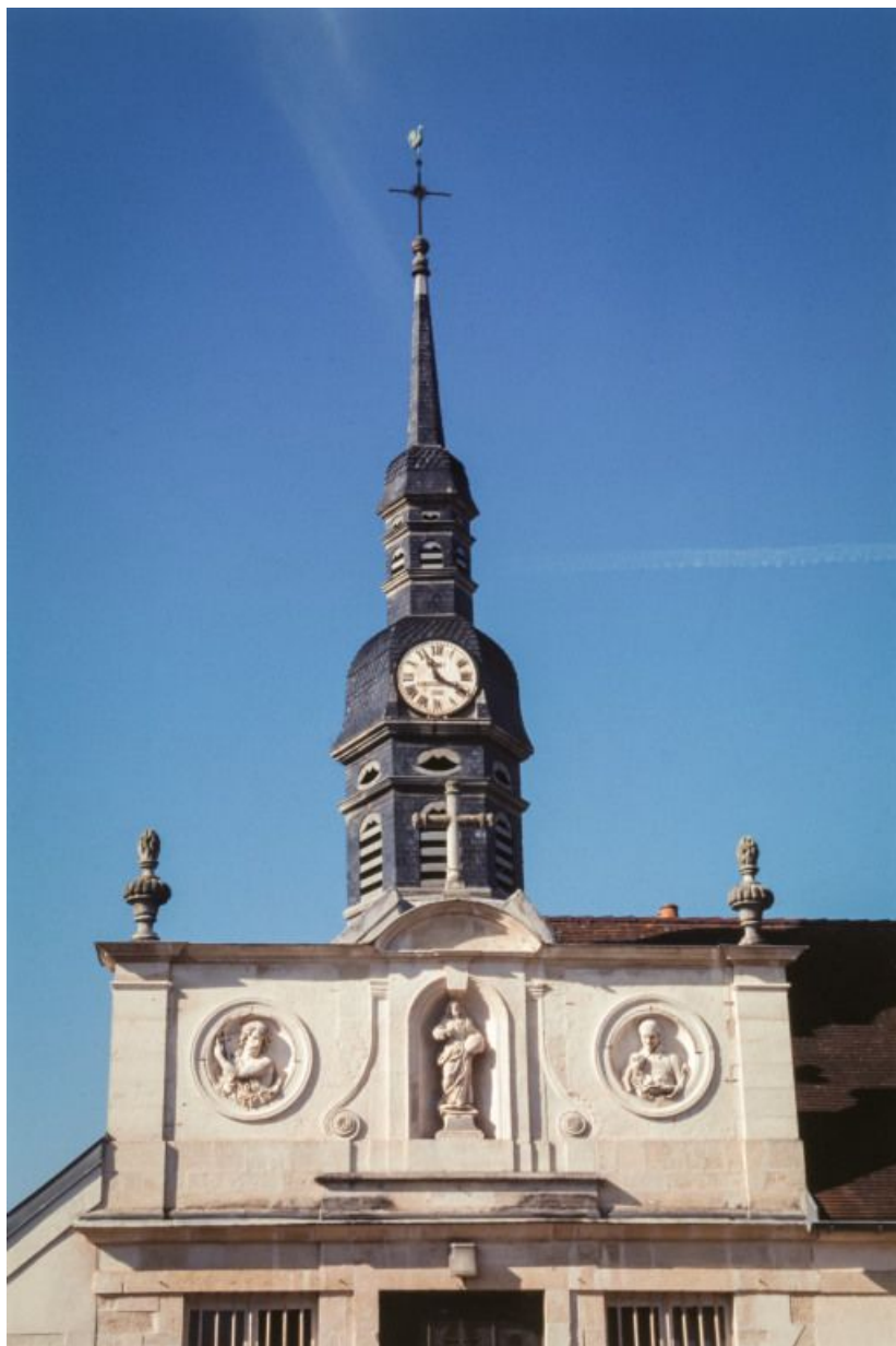
Façade de la chapelle : partie supérieure. 21, Moutiers-Saint-Jean, 8 place de l' Hôpital
