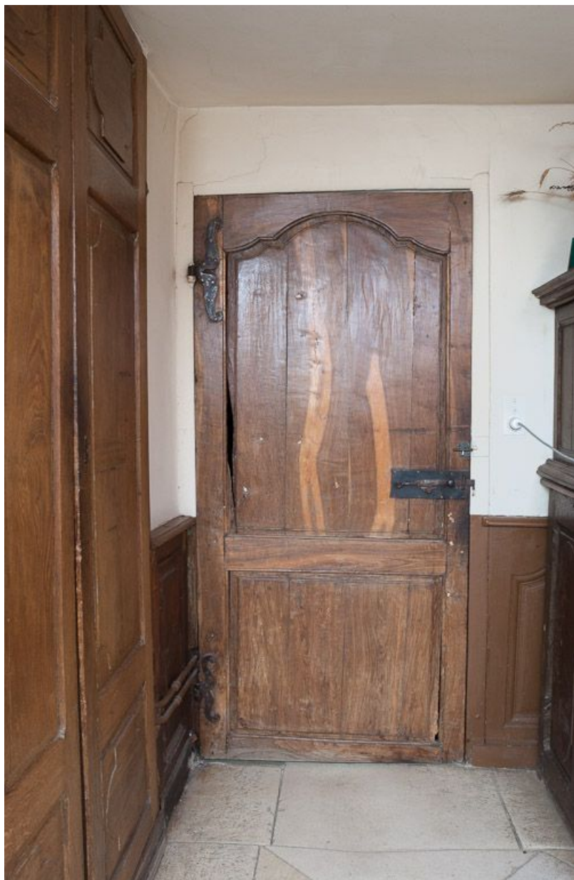
Corps de bâtiment principal : deuxième pièce latérale gauche, devenue sacristie (détail : porte antérieure). 21, Moutiers-Saint-Jean, 8 place de l' Hôpital
