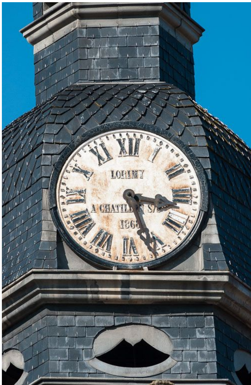
Façade sur rue : détail (cadran de l'horloge).
