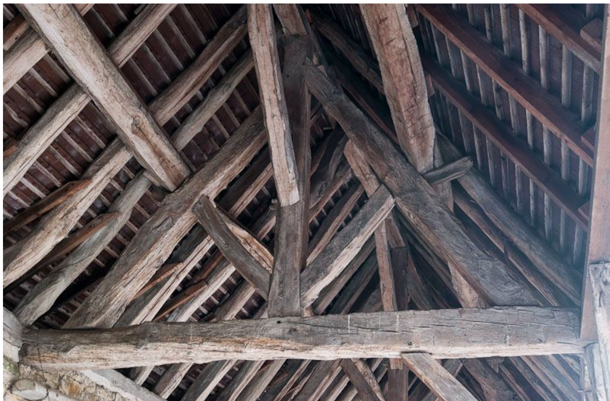
Cour latérale gauche : charpente du hangar.
