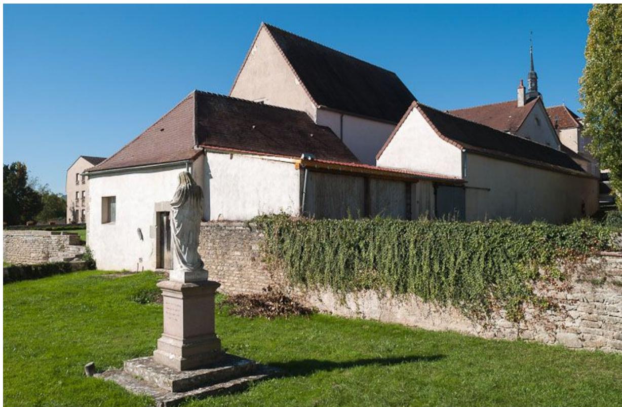
Vue d'ensemble : ancien bâtiment du pressoir, ancien bûcher transformé en "salle d'asile" et hangar (vue prise de l'est). 21, Moutiers-Saint-Jean, 8 place de l' Hôpital
