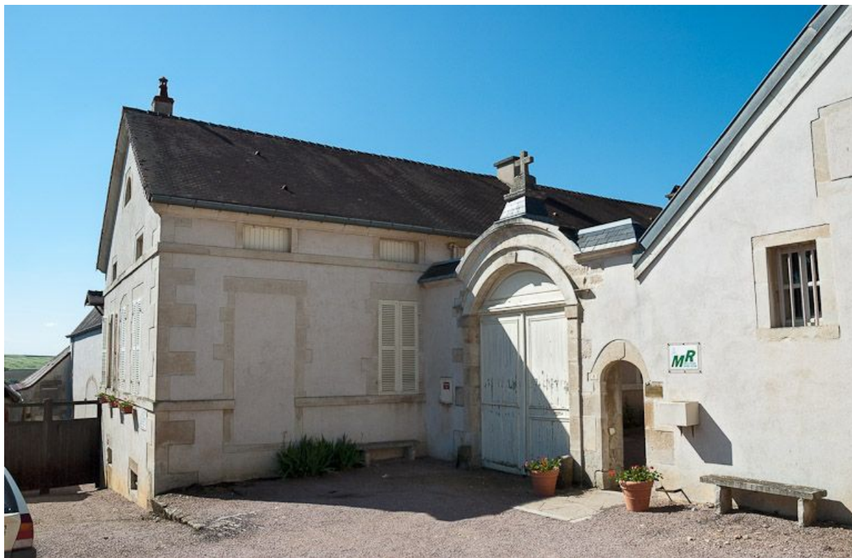
Façade sur rue : vue partielle (portail et corps de bâtiment latéral gauche).
