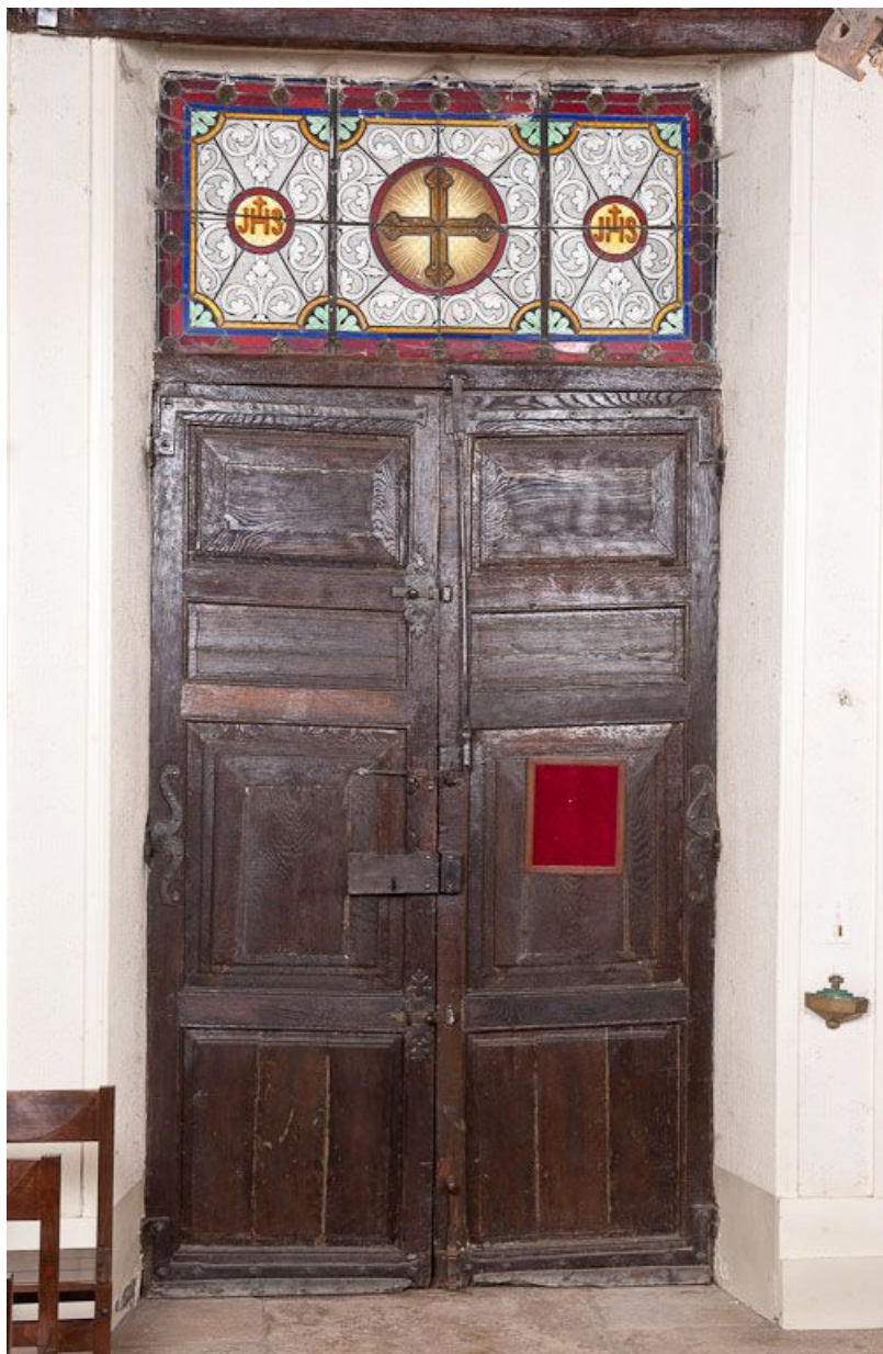
Corps de bâtiment principal : salle des hommes devenue chapelle, porte d'entrée principale.
