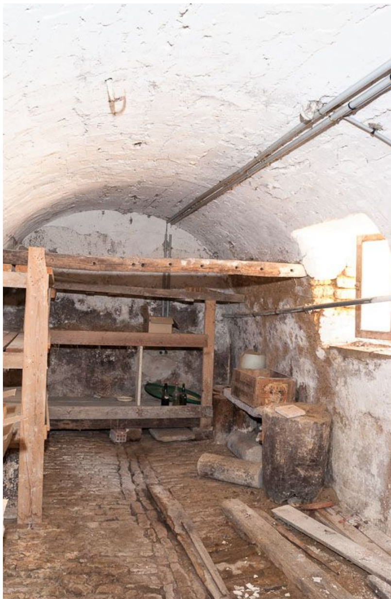
Corps de bâtiment principal : cave située sous l'angle antérieur gauche du bâtiment.
