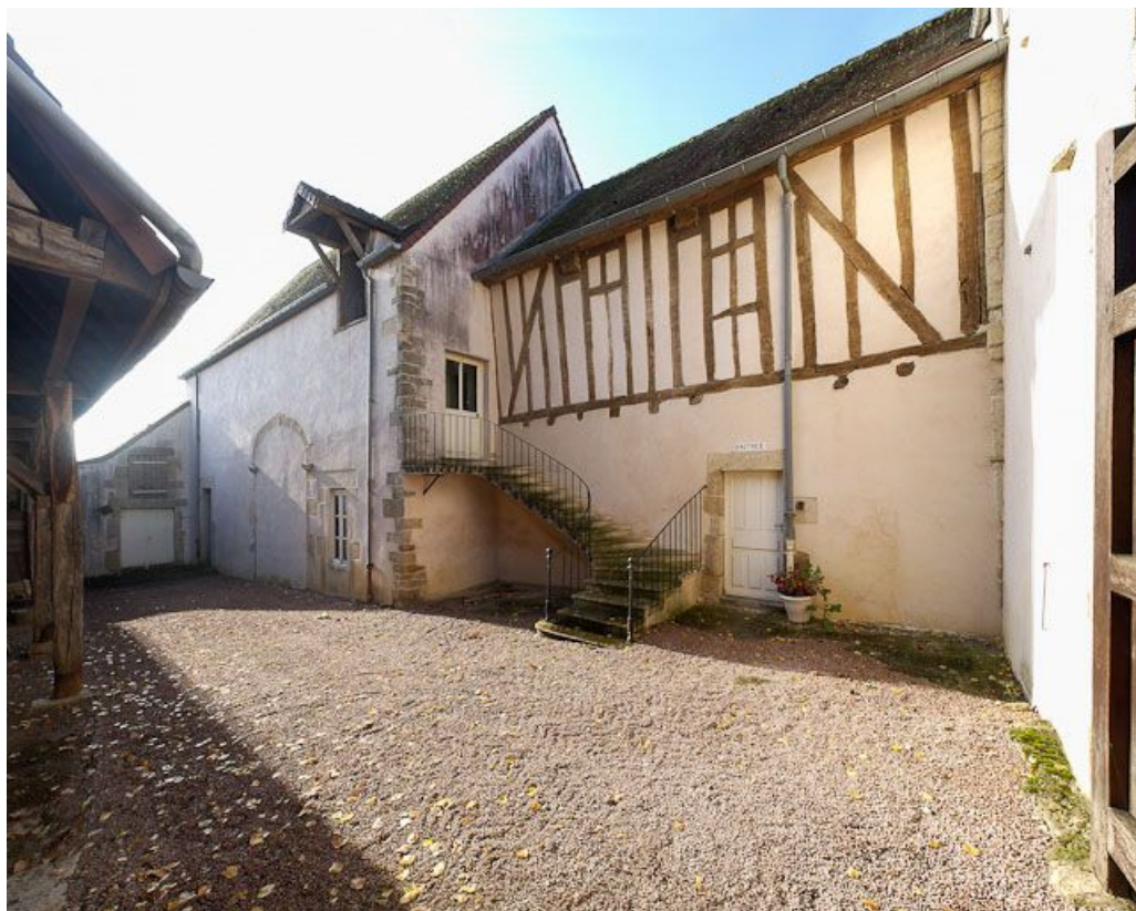
Cour latérale gauche : élévation nord du bâtiment de l'apothicairerie et de l'ancien bûcher transformé en "salle d'asile". 21, Moutiers-Saint-Jean, 8 place de l' Hôpital
