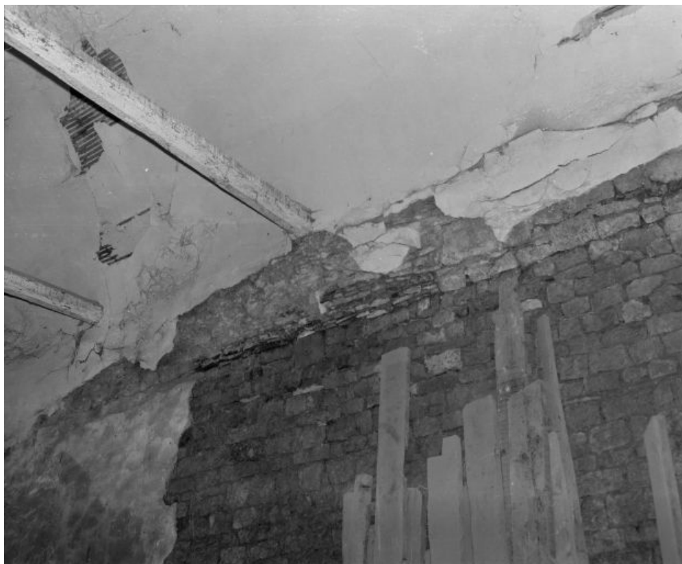
Mur gauche de la nef, détail.
