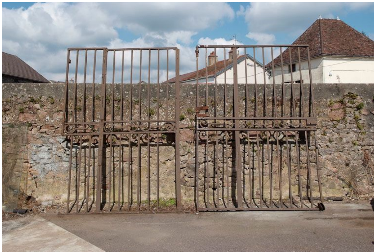
Ancien portail de la cour.
