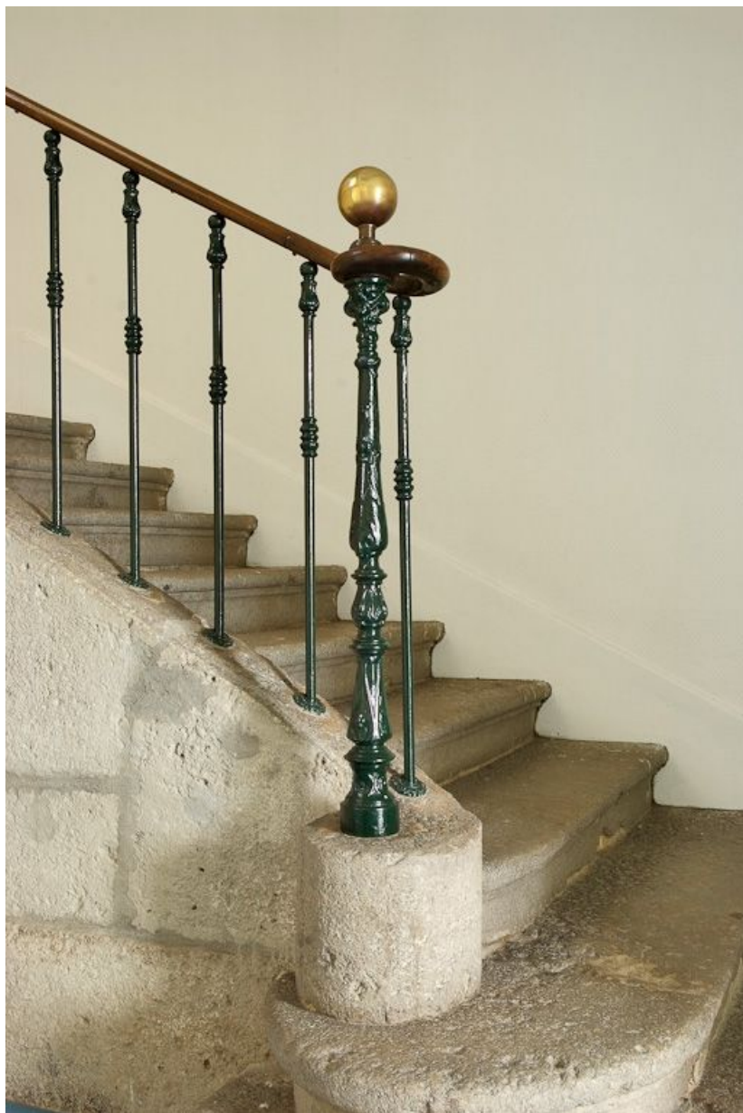
Escalier du vestibule à gauche de la chapelle, détail. 21, Saulieu Courtépée
