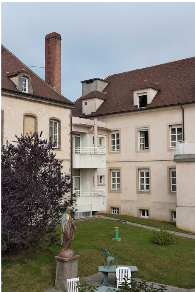
Angle formé par l'ancien hôpital et le nouveau bâtiment nord. 21, Saulieu Courtépée
