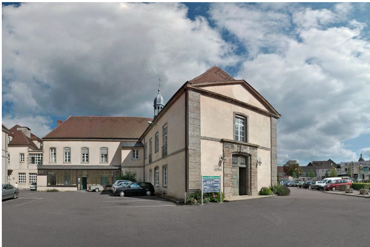
Partie gauche du bâtiment principal et corps perpendiculaire dans l'axe de la chapelle. 21, Saulieu Courtépée
