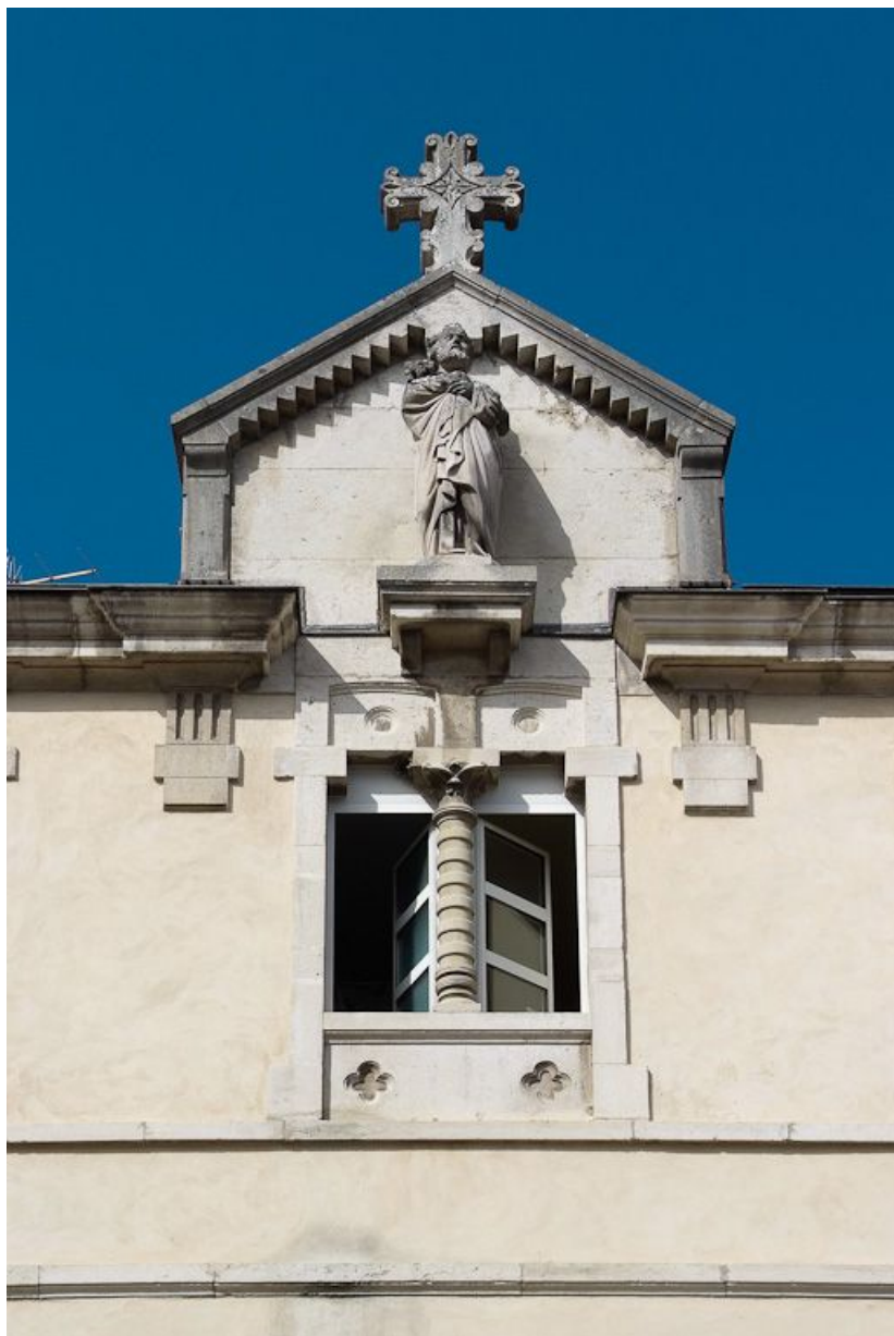
Ancien bâtiment des vieillards, travée centrale : détail de la fenêtre de l'étage et du couronnement. 21, Saulieu Courtépée
