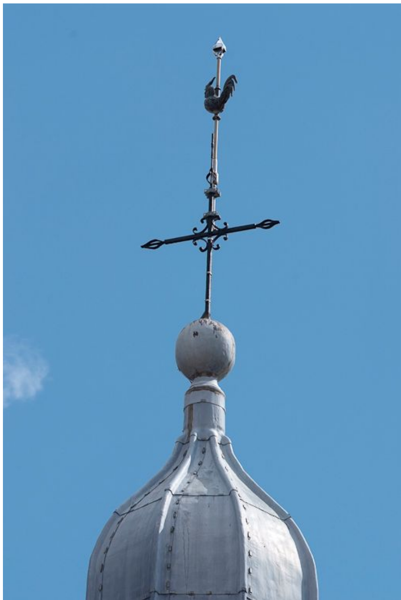
Détail du campanile. 21, Saulieu Courtépée
