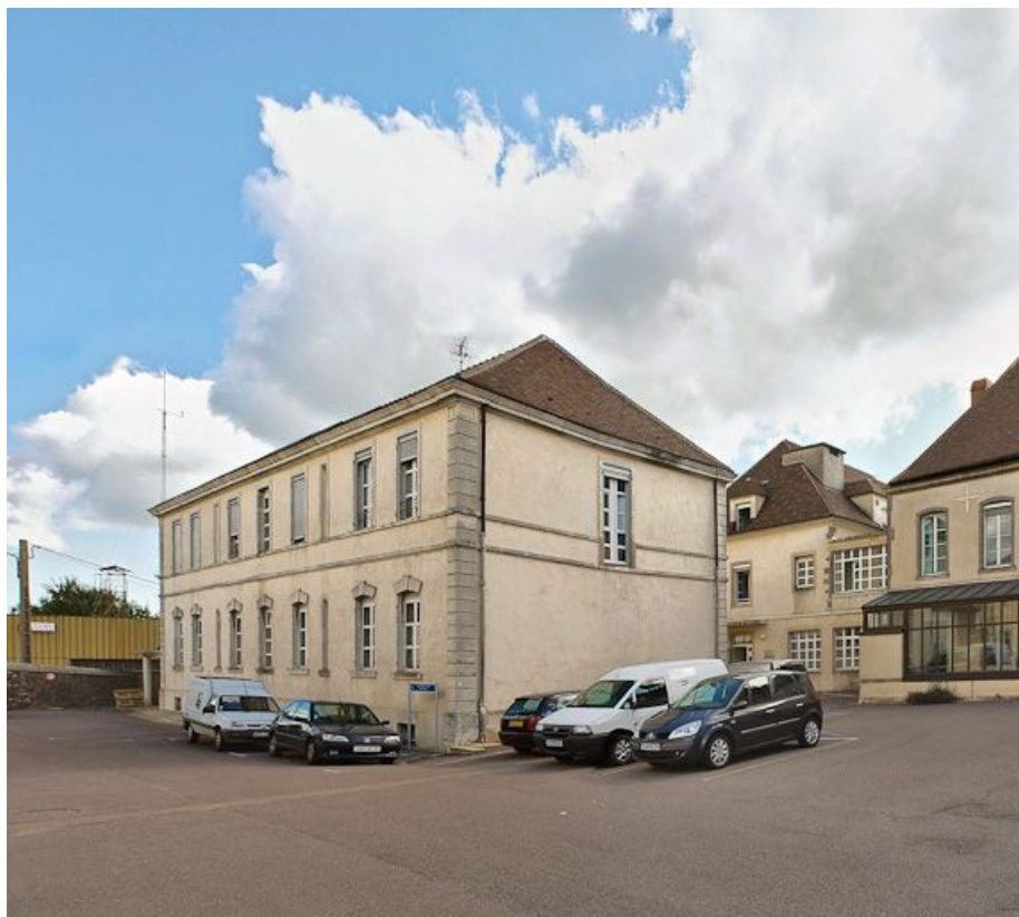
Ancien bâtiment des vieillards, élévations postérieure et gauche. 21, Saulieu Courtépée
