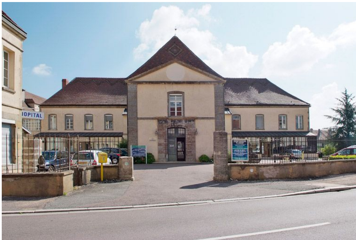
Vue d'ensemble depuis la rue.
