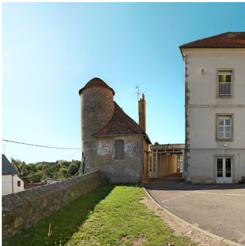
Construction ancienne incluant la tour de Poilbourg.
