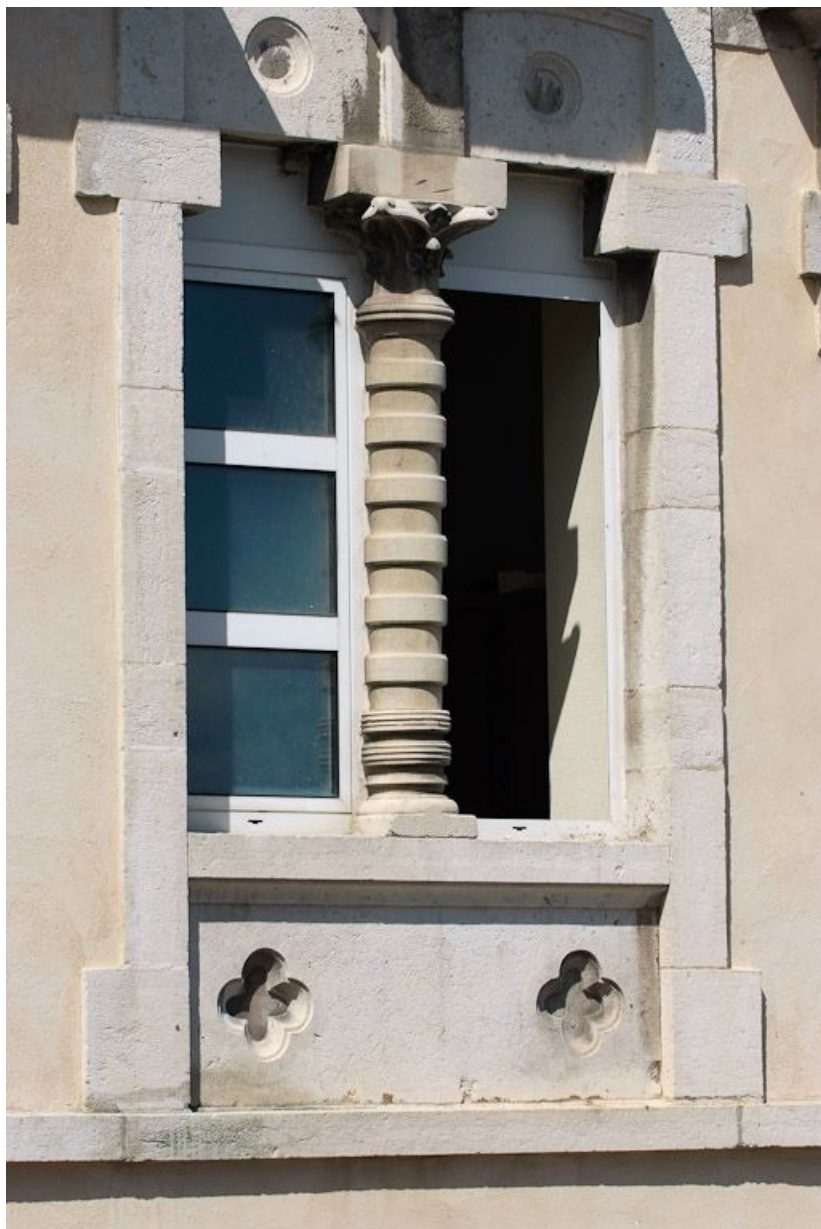
Ancien bâtiment des vieillards, travée centrale : fenêtre de l'étage. 21, Saulieu Courtépée
