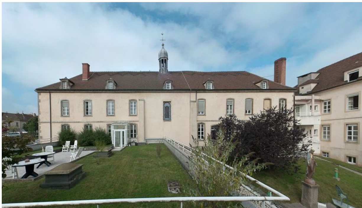
Façade postérieure du bâtiment principal.
