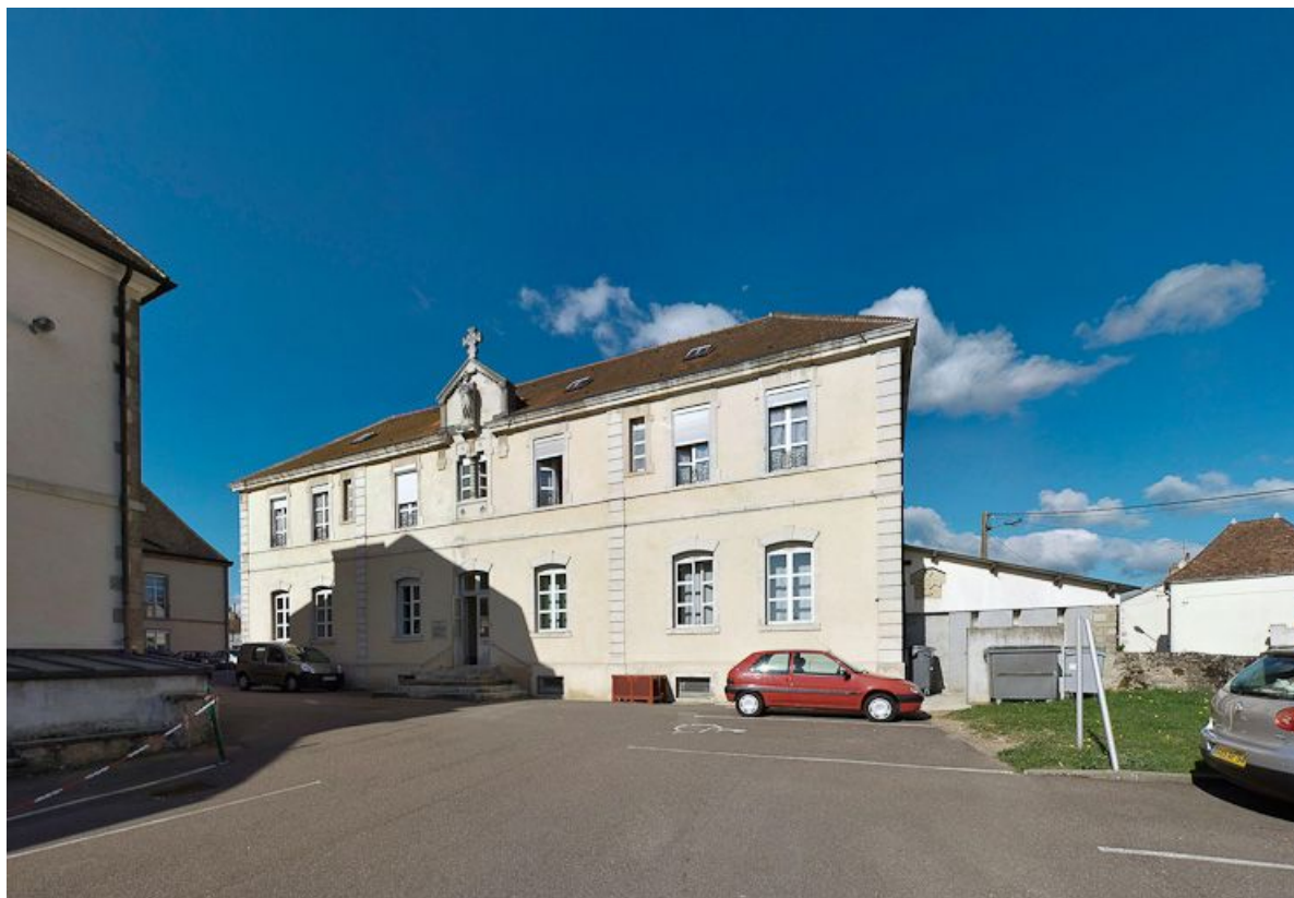
Ancien bâtiment des vieillards : façade. 21, Saulieu Courtépée
