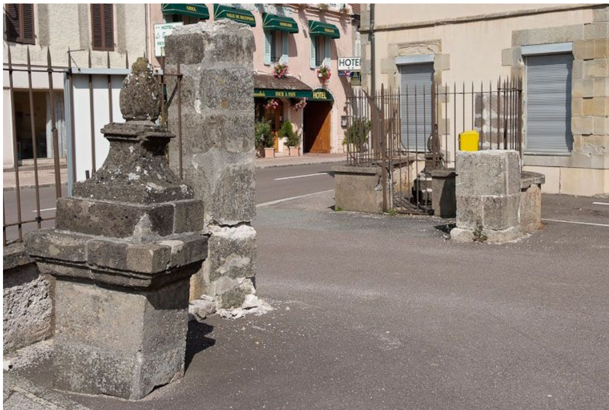
Vestiges du portail d'entrée.
