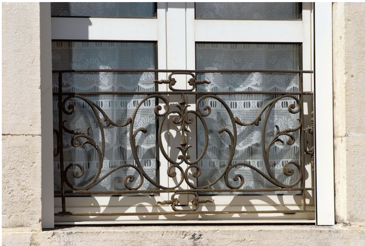
Ancien bâtiment des vieillards : détail d'un garde-corps. 21, Saulieu Courtépée
