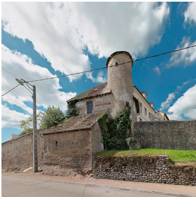
Construction ancienne incluant la tour de Poilbourg.
