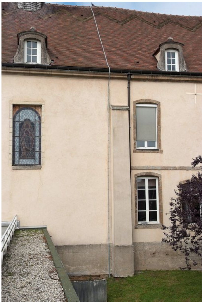
Façade postérieure du bâtiment principal : mur postérieur de la chapelle et contrefort. 21, Saulieu Courtépée
