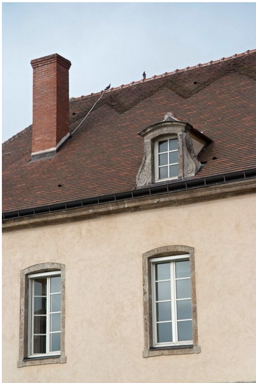
Façade postérieure du bâtiment principal : détail.
