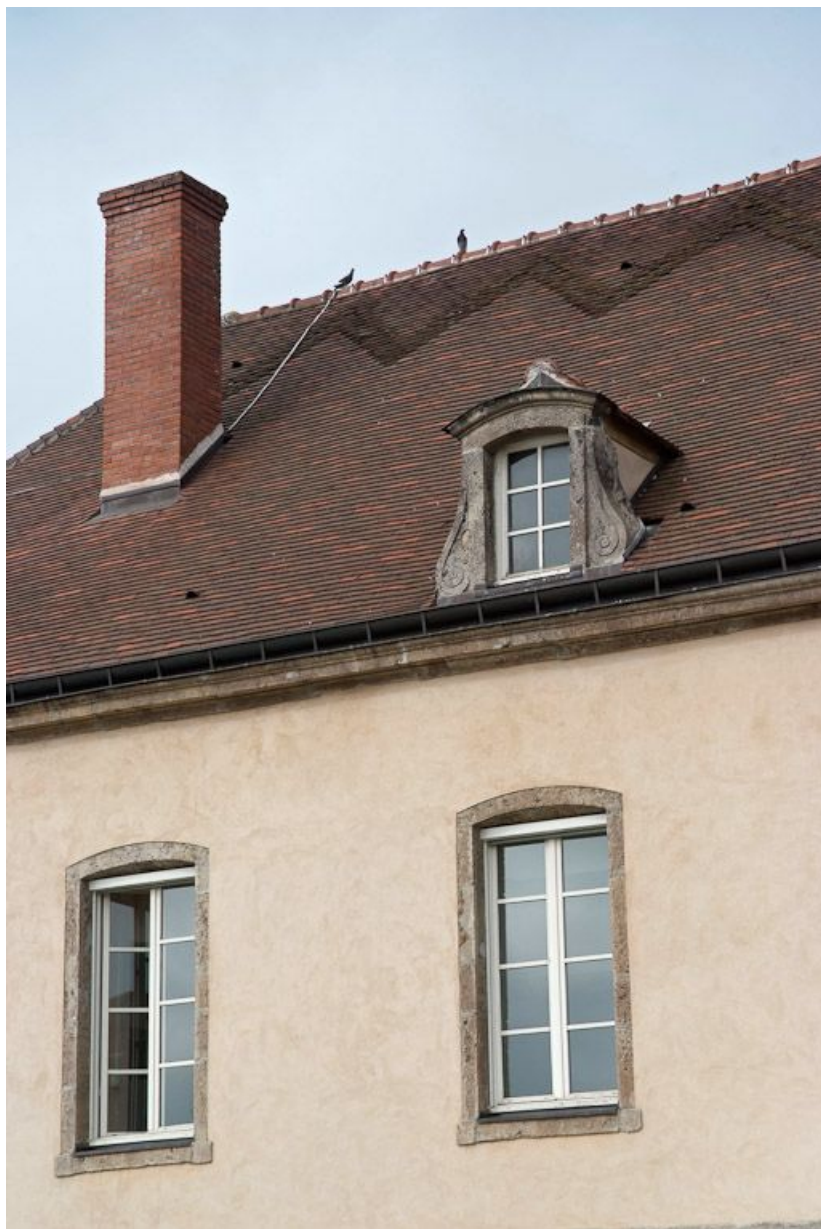
Façade postérieure du bâtiment principal : détail.
