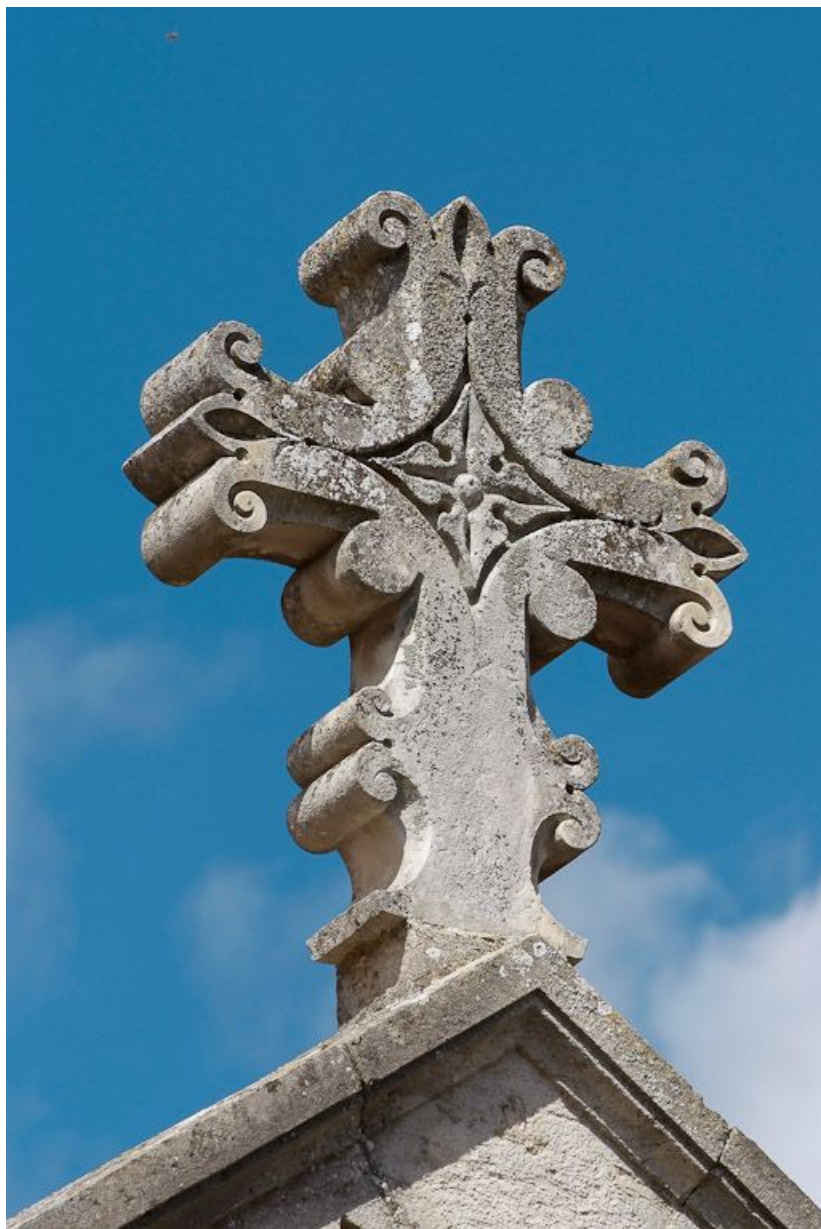
Ancien bâtiment des vieillards, travée centrale : croix du couronnement. 21, Saulieu Courtépée
