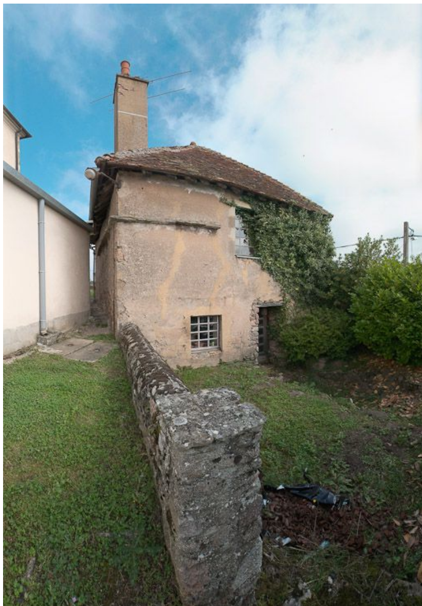
Construction ancienne incluant la tour de Poilbourg.
